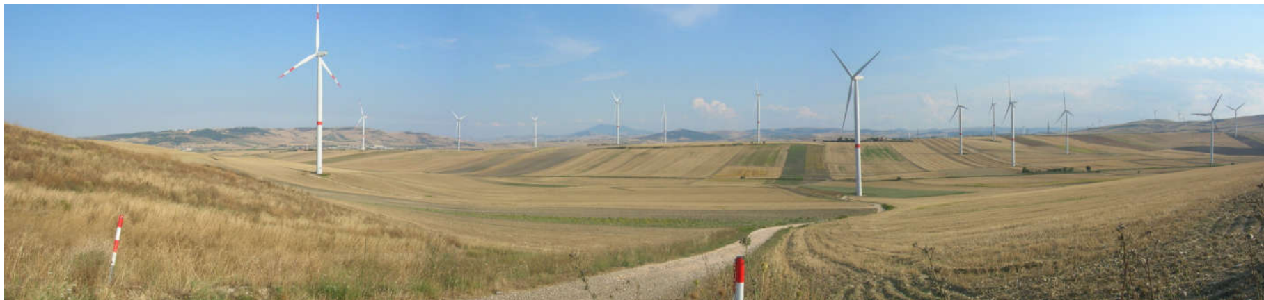
Fotografia n. 14 – valle del corridoio ecologico “Fosso Traversa e Pozzo Pascuscio” del PPTR da nord (da SP120) verso sud e strada interessata dal cavidotto interrato esterno.
