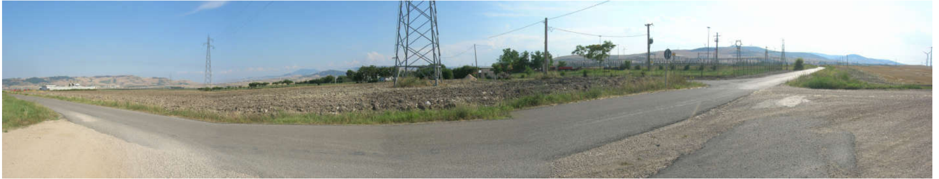
Fotografia n. 10 – area stazione elettrica da strada comunale Deliceto-Ascoli verso sud.
