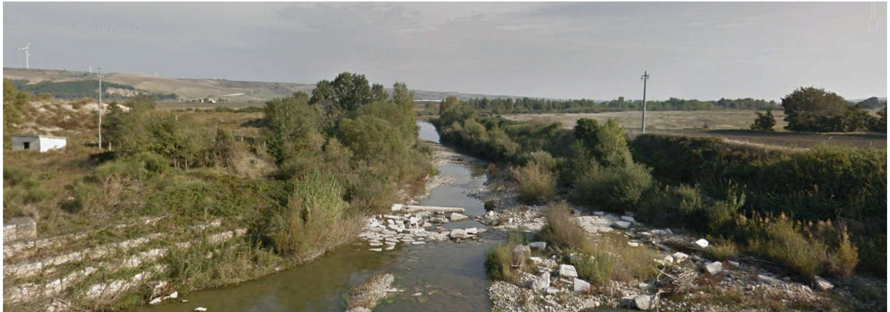
Fotografia 4 - Torrente Cervaro da ovest verso est (da ponte SP106).
