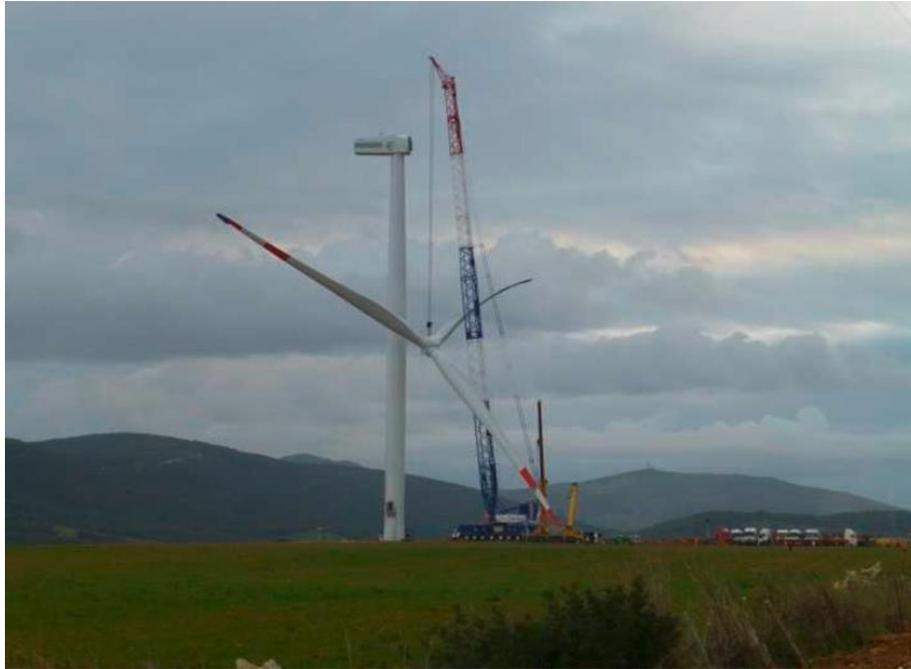
**Figura 3:** Montaggio dell'aerogeneratore
