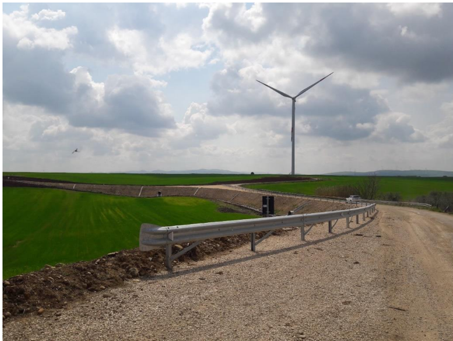
Figura 10: Manutenzione segnaletica stradale – Impianto Eolico di Proprietà – Basilicata
