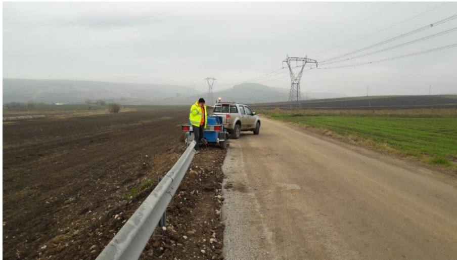
Figura 6: Argano per il tiro di nuovi cavi in tubazioni corrugate sotterranee
