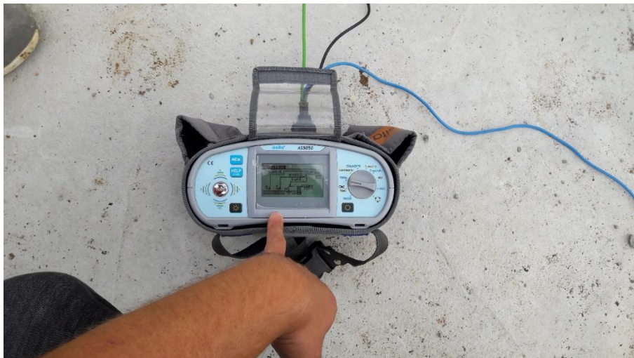
Figura 9: Attività di verifica dello stato della rete di terra – Impianto Eolico di Proprietà – Basilicata
