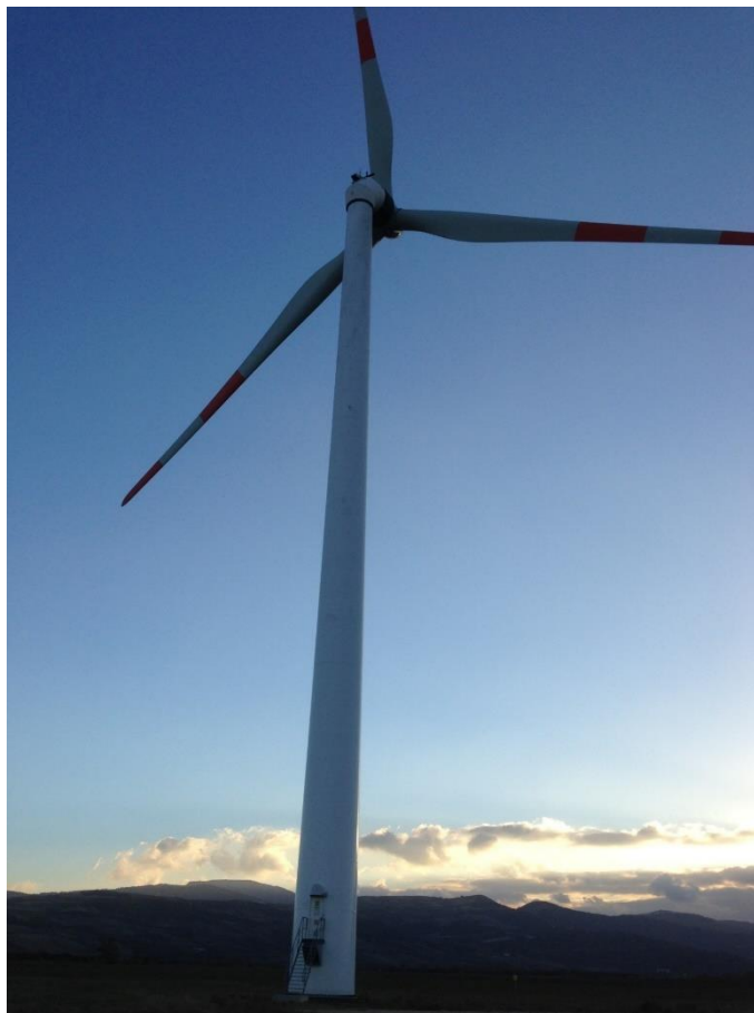
Figura 14: Pulizia grasso lubrificante da cuscinetto principale – Impianto Eolico di Proprietà – Puglia
