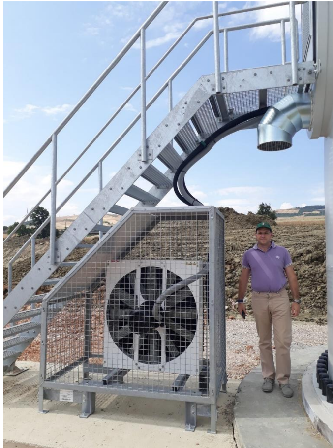
Figura 17: Installazione sistema di raffreddamento esterno – Impianto Eolico di Proprietà – Puglia
