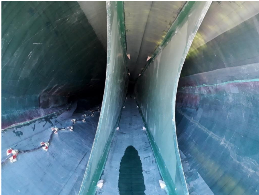
Figura 13: Ispezione interno pale – Impianto Eolico di Proprietà – Basilicata
