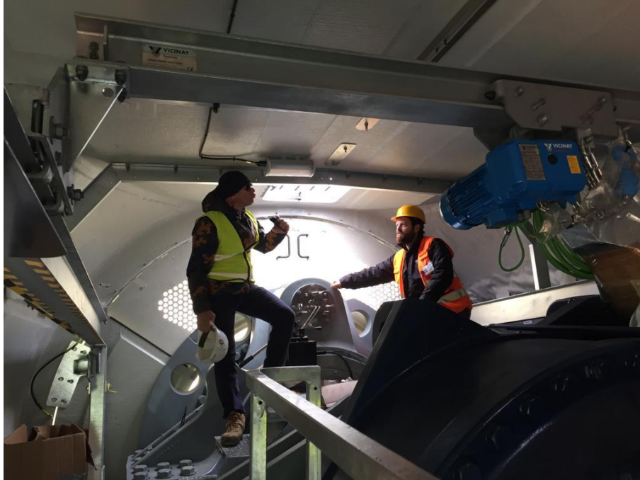
Figura 1: Attività di controllo interne alla navicella – Parco Eolico di Proprietà - Puglia
