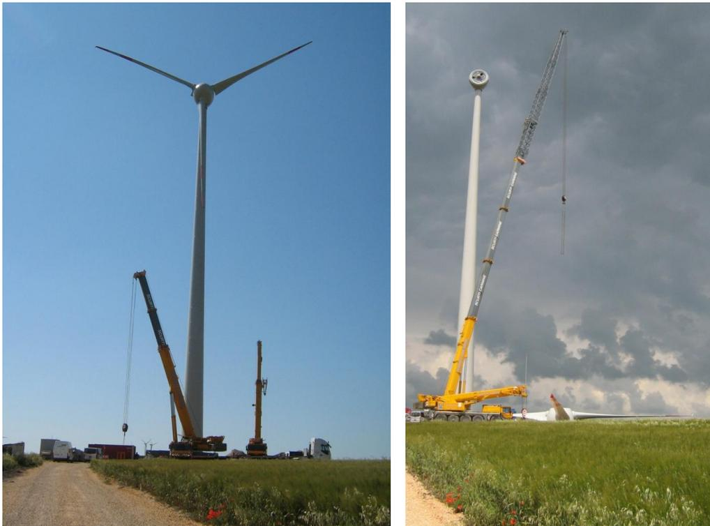
**Figura 2:** rimozione eliche e mozzo
