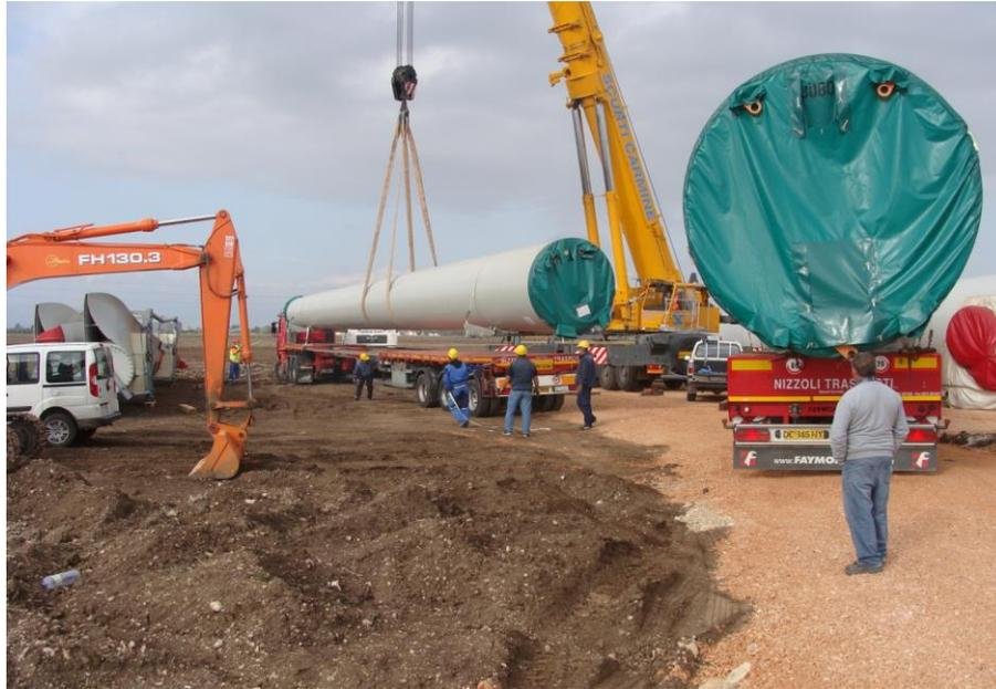
**Figura 6:** elementi torre smontata da trasportare
