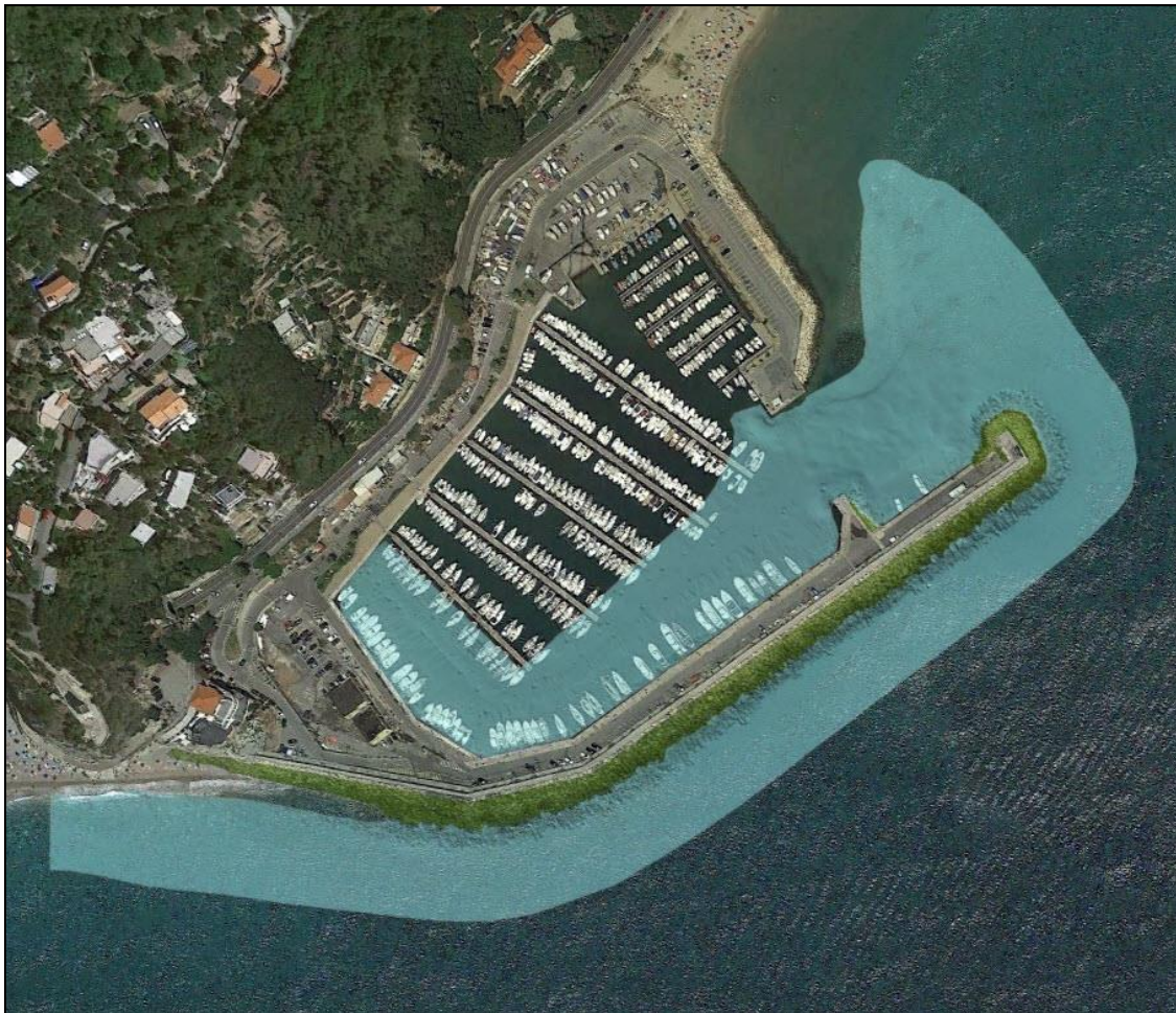
Fig. 4.1 : Area d'indagine e zona del rilievo: Finale Ligure
