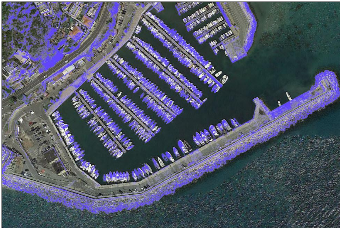
Fig 4.6 - Laser Scanner Riegli z420i: copertura dati laser scanner.
