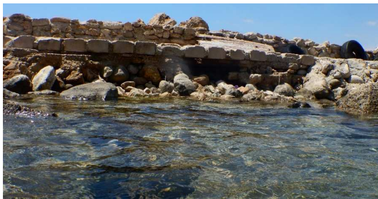
Figura 4: Stato di deterioramento della struttura di banchina
