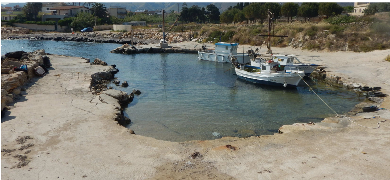
Figura 3: Stato di fatto area bacino interno esistente
