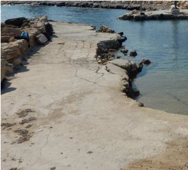
Figura 4: Stato di deterioramento della struttura di banchina
