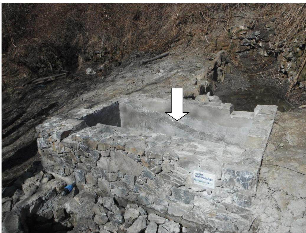
Figura 2-9 - Esempio di abbeveratoio con rampa interna di risalita per gli Anfibi
