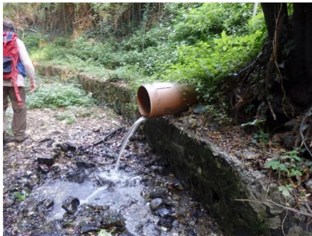
Figura 3 – Panoramica dell'alveo del rio Ronco da monte verso valle; la sponda sinistra è rivestita con un muro in pietrame parzialmente in dissesto per la spinta del versante e per lo scalzamento al piede da parte dei flussi del rio.
