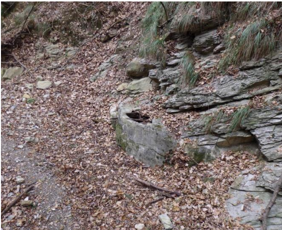
Figura 22 – Sorgente S641; bottino di presa in sponda destra.
