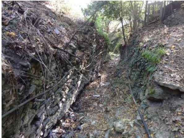
Figura 3 – Panoramica dell'alveo del rio Ronco da monte verso valle; la sponda sinistra è rivestita con un muro in pietrame parzialmente in dissesto per la spinta del versante e per lo scalzamento al piede da parte dei flussi del rio.
