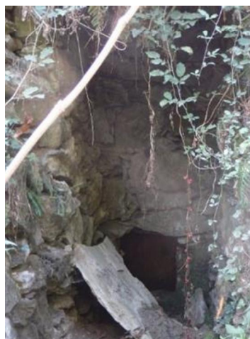
Figura 2 – Vecchia captazione attualmente asciutta.
