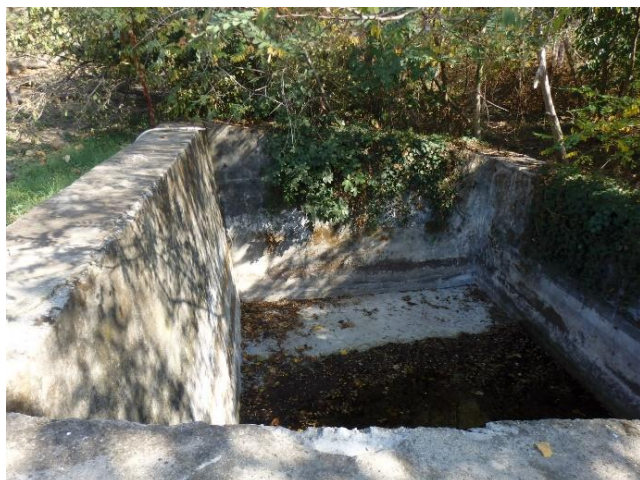
Figura 10 – Nella foto a sinistra la vasca di accumulo in disuso, posta subito a monte della carreggiata Ovest della A7, verosimilmente alimentata dalla sorgente S606 e forse anche dalla S607. Nella foto a destra la vasca di accumulo della “sorgente” S607.
