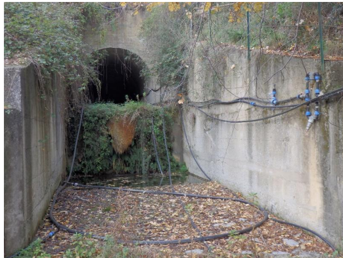
Figura 16 - Sbocco lato valle dell'opera di attraversamento della rampa di accesso all'autostrada esistente. Dal fondo alveo affiora una venuta idrica che riempie i salti del tratto di alveo rivestito. Tali acque vengono sfruttate da diverse opere di presa (PS009) piuttosto precarie costituite da succhiaruole e tubi in PVC.
