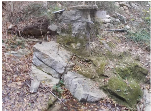
Figura 18 – Sorgente S639, bottino di presa e infiltrazioni alla base dello stesso.
