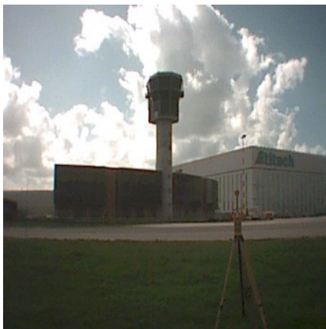
Foto 9 – punto 12 – Hangar Atitech
