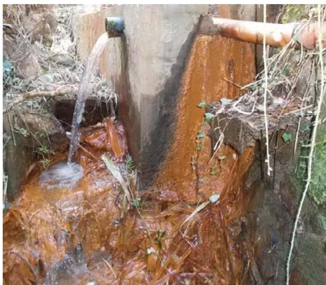
**Figura 3-3: Scarico del drenaggio della galleria Borgonuovo della A10 (S209). La formazione di evidenti concrezioni di ossidi di ferro attesta che si tratta di acque che si sono evolute in ambienti fortemente riducenti.**
