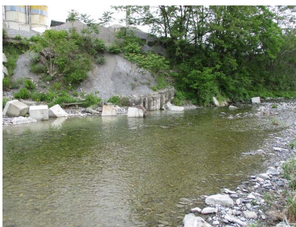
Figura 3-12: cumulo di sabbie in corrispondenza della sezione NG-GE-SU-SE-37.
