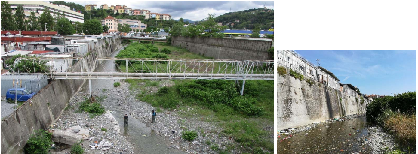
Figura 3-10: scarichi attivi in destra idrografica sul torrente Burla.
