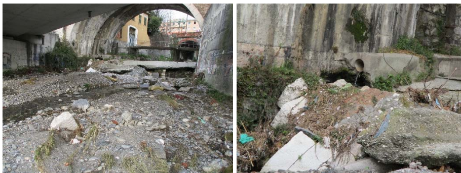
Figura 3-16: scarichi in corrispondenza della sezione NG-GE-SU-PO-34.
