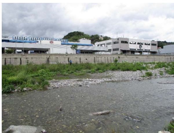
Figura 3-13: scarichi in corrispondenza della sezione NG-GE-SU-SE-38.
