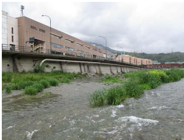
Figura 3-15: scarichi in corrispondenza della sezione NG-GE-SU-PO-32.
