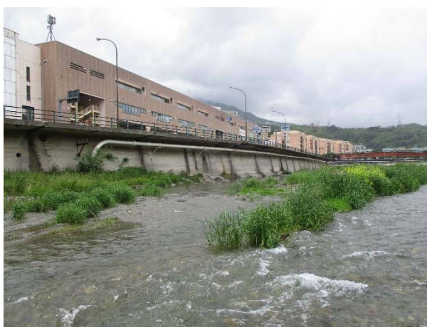
Figura 3-15: scarichi in corrispondenza della sezione NG-GE-SU-PO-32.
