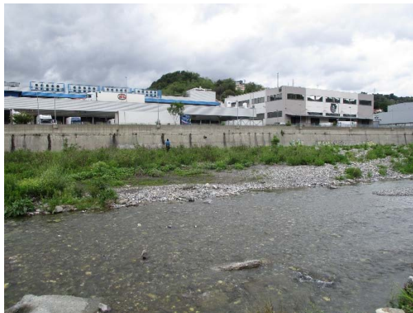
Figura 3-13: scarichi in corrispondenza della sezione NG-GE-SU-SE-38.
