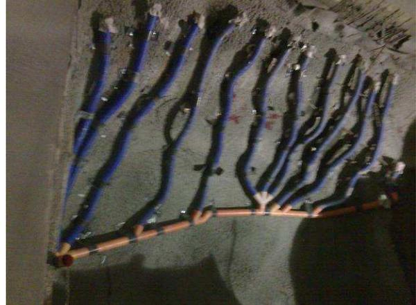
Figura 7 - Nicchia nella galleria da cui si dipartono i dreni perforati in roccia (immagine a sinistra) e sistema di dreni perforati negli ammassi rocciosi a lato e soprastanti la galleria (immagine a destra).
