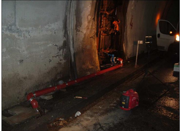
Figura 6 - Sistema di dreni e valvole entro nicchia (immagine a sinistra) e linea di collegamento tra i dreni ed il collettore principale di adduzione all'esterno della galleria (immagine destra).
