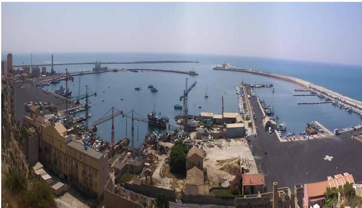
La darsena interna presenta attualmente il banchinamento sul lato interno del molo interno di levante, ed un tratto di banchina, per una lunghezza di m 260 circa, lungo la riva nord (Banchina Marinai d'Italia).
