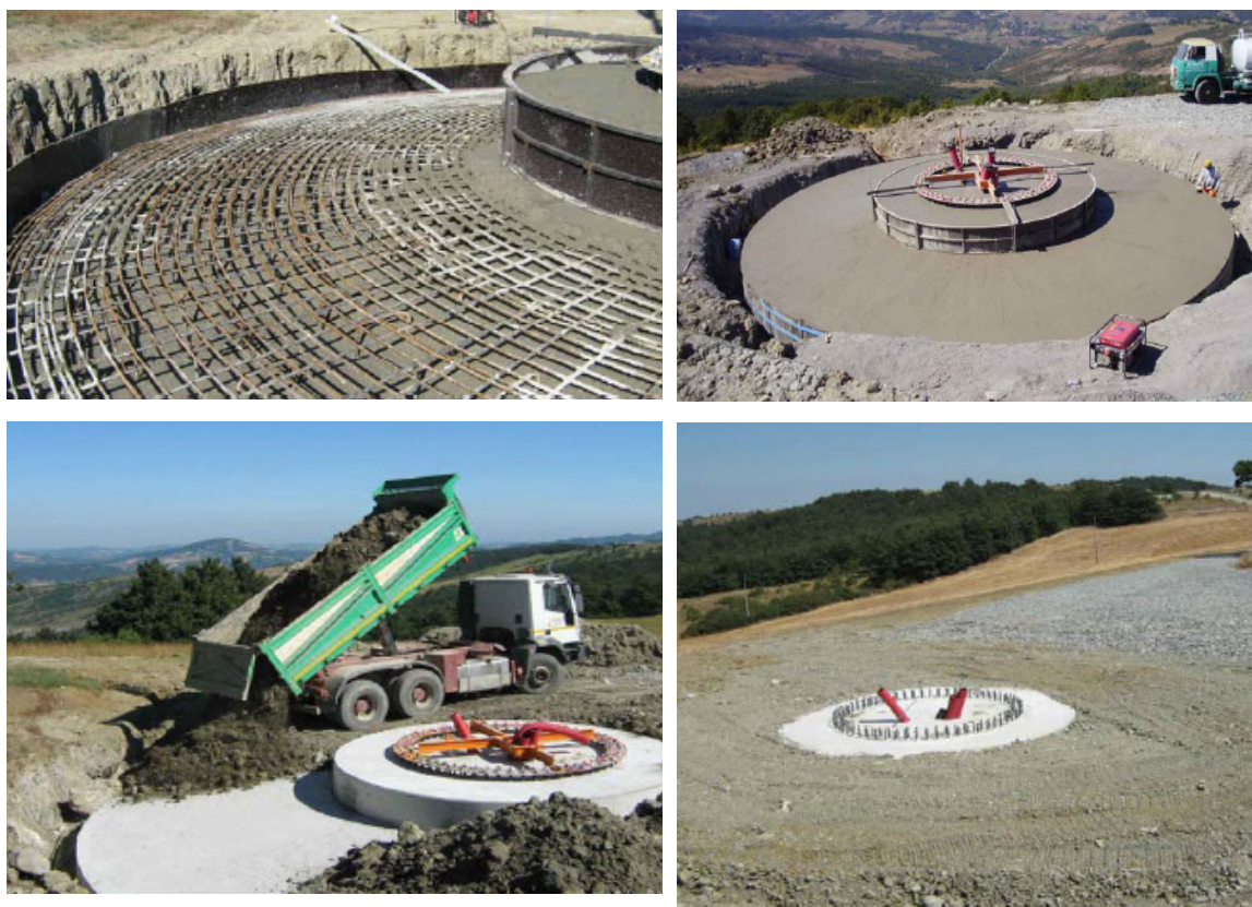
Foto 11 - Particolare esecuzione plinti di fondazione
