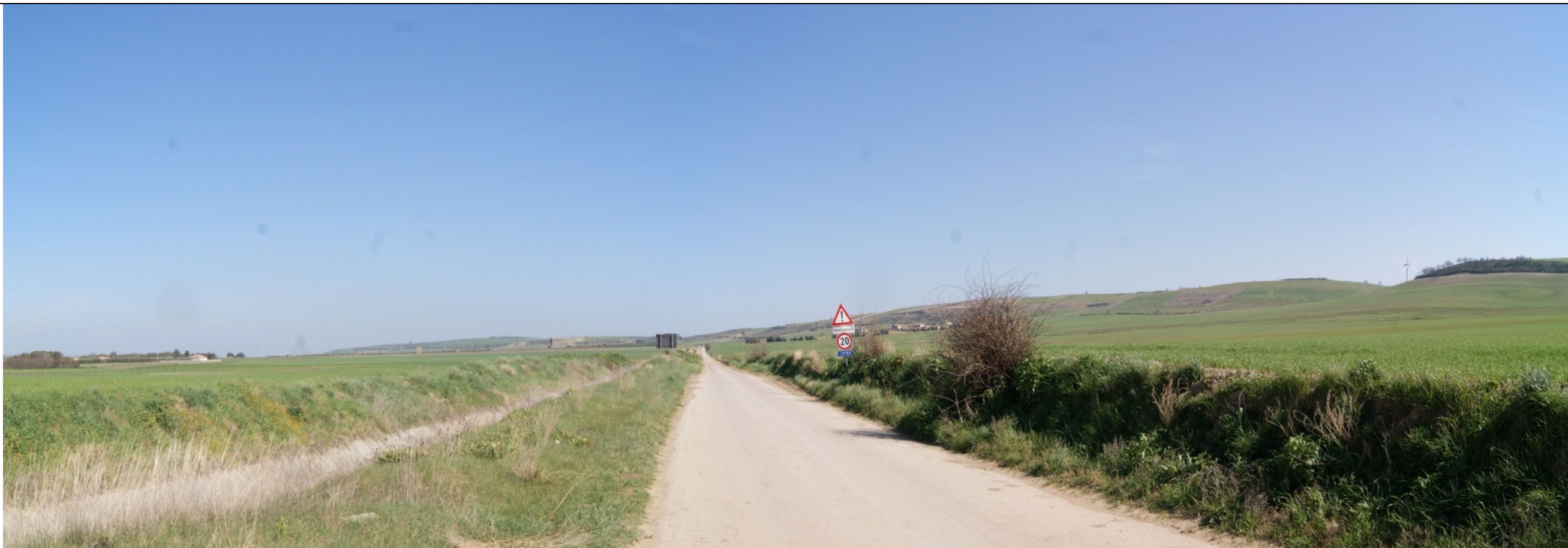
Foto 10 - Vista panoramica del gruppo di aerogeneratori WTG4 – WtG5 WTG6 WTG7 dall' incrocio tra le SP 52 e SP 18 verso nord
