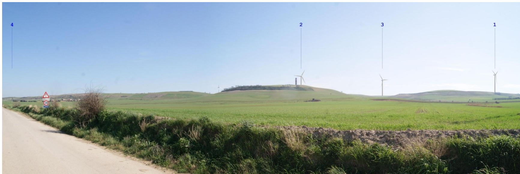
Figura 69 - Fotoinserimento 4B - DALL'INCROCIO DELLE STRADE STATALI SP 52 E SP 18 - SP 18 - VISUALE SUD DEL PARCO (WTG01 - WTG02 - WTG03)
