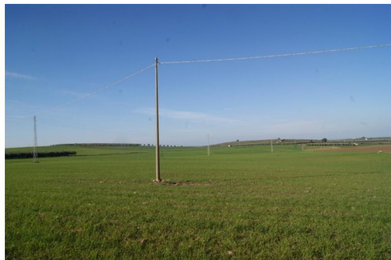
Foto 7 - Vista del parco eolico di progetto - area di ubicazione della WTG7
