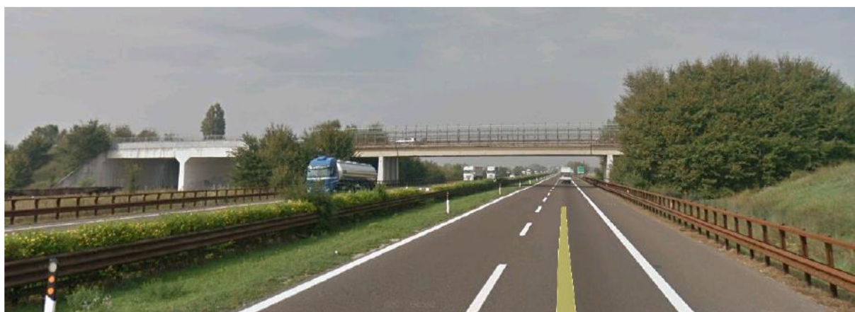
Figura 3: Veduta del sovrappasso n. 108 esistente da Sud (Fonte: Allegati alla Lista di controllo)
