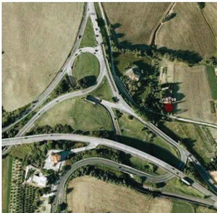
Figura 13. Punto di indagine componente vibrazione (VIB_08)
