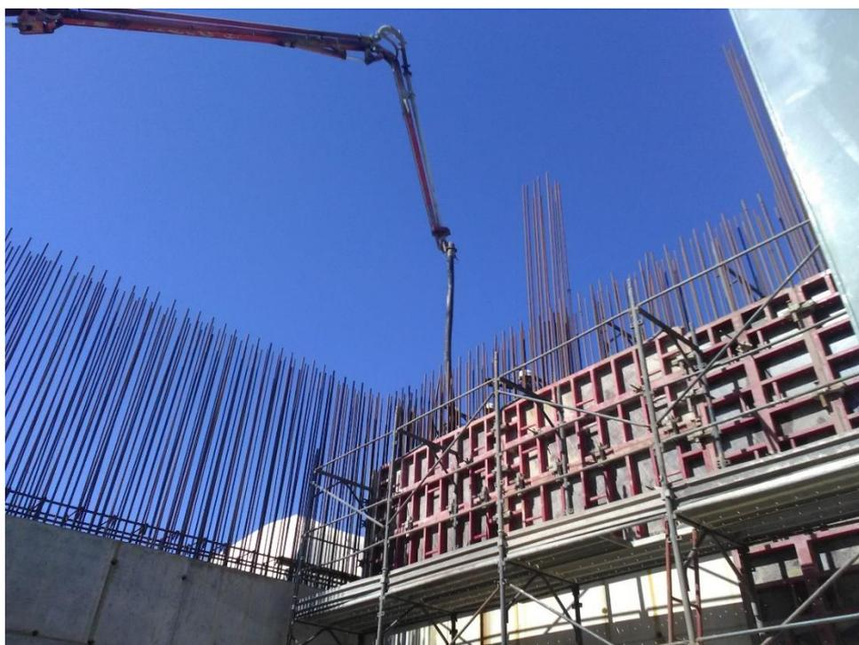
Figura 3-2: Foto di cantiere durante il getto delle strutture in elevazione
