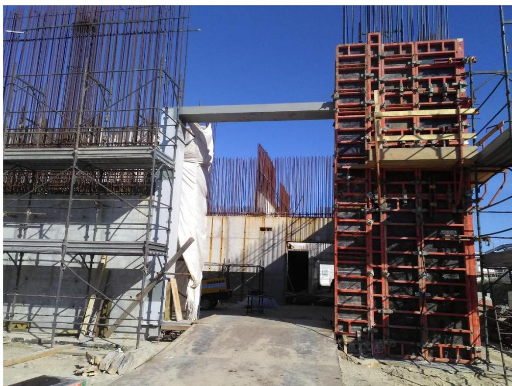
Figura 3-4: Foto di cantiere durante il getto delle strutture in elevazione
