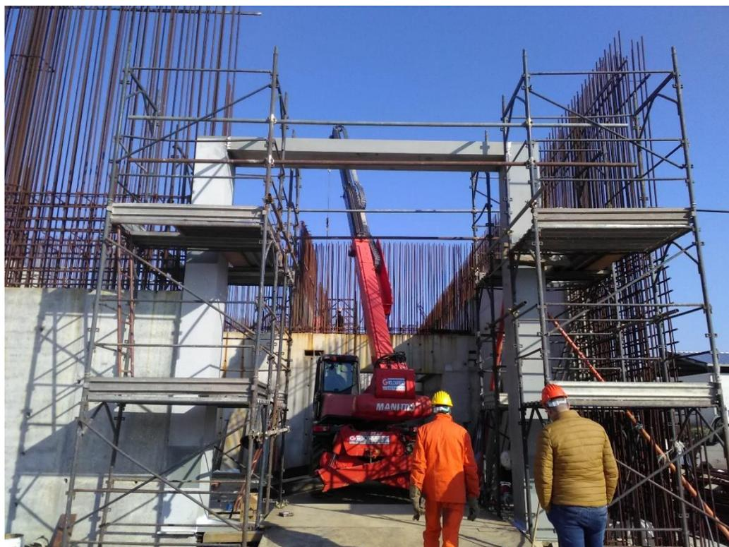
Figura 3-3: Foto di cantiere durante la posa in opera dei telai
