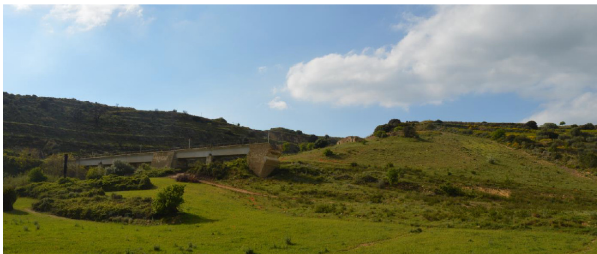
Fig.4.1 – Viadotto in c.a. da demolire
