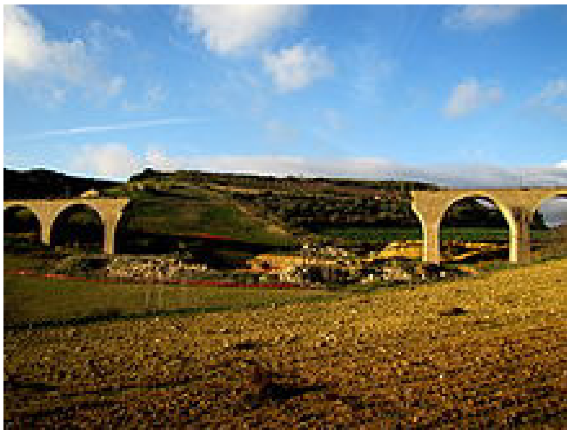
Fig.1.1 - viadotto crollato in contrada "Discesa degli angeli" al km 326+645
