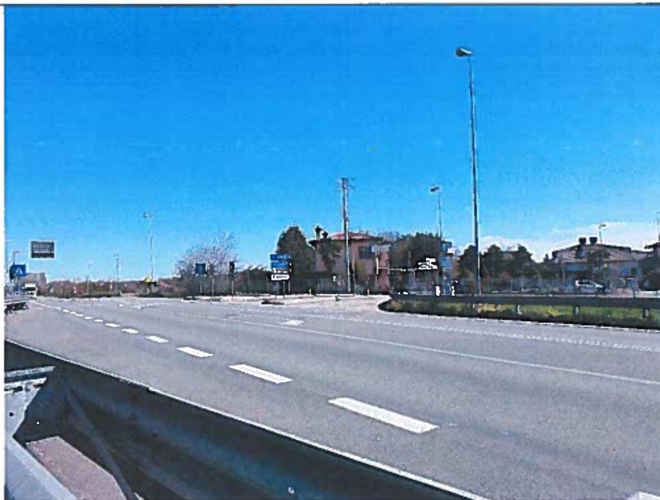
Fig. 5 – Foto B – Vista su S.S. “Romea” – incrocio con Via Malcanton
