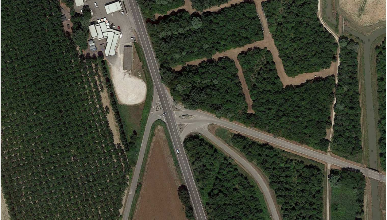
Fig. 4.2 – Ortofoto dell'area d'intervento
