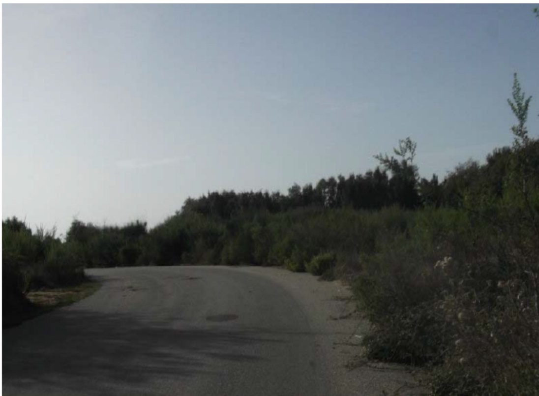
Figura 14 stato di fatto delle strade bitumate interne al parco eolico
