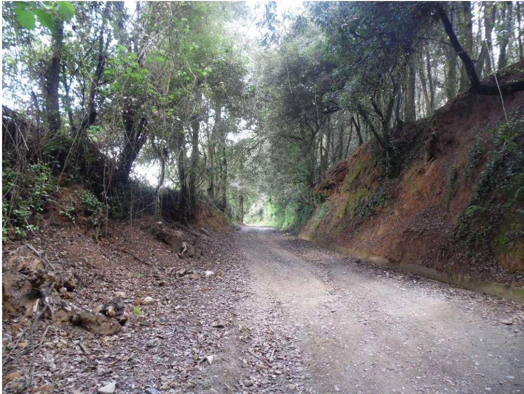
Figura 13 stato attuale della viabilità interna sterrata
