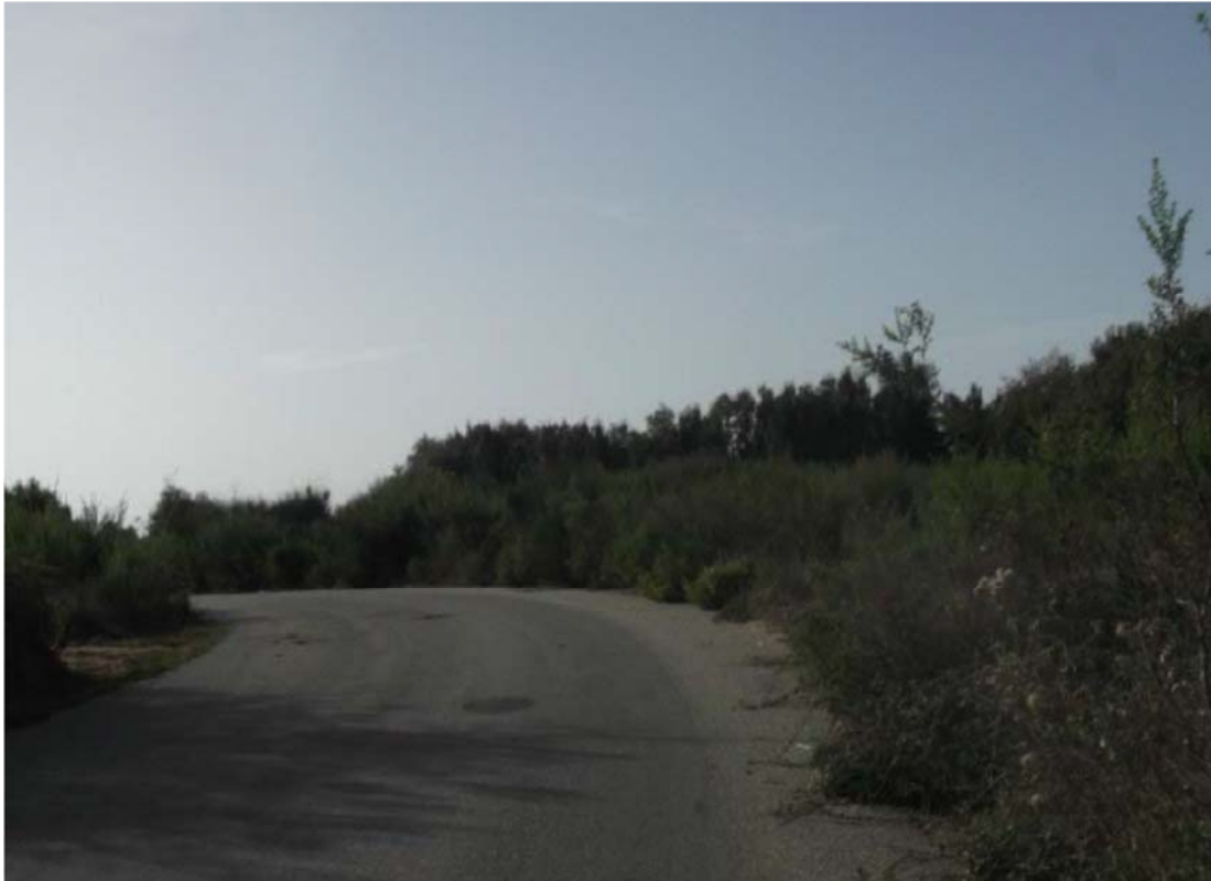
Figura 7: Stato di fatto delle strade bitumate interne al parco eolico
