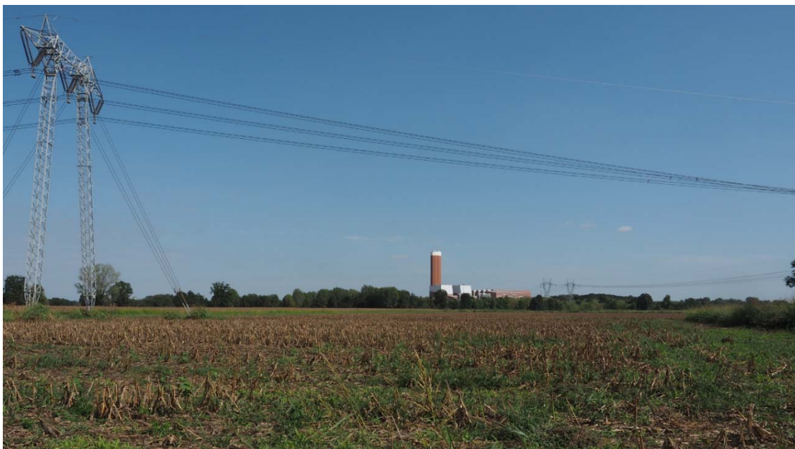
Figura 4-41: Vista della Centrale Sorgenia Power da Sud-Ovest
