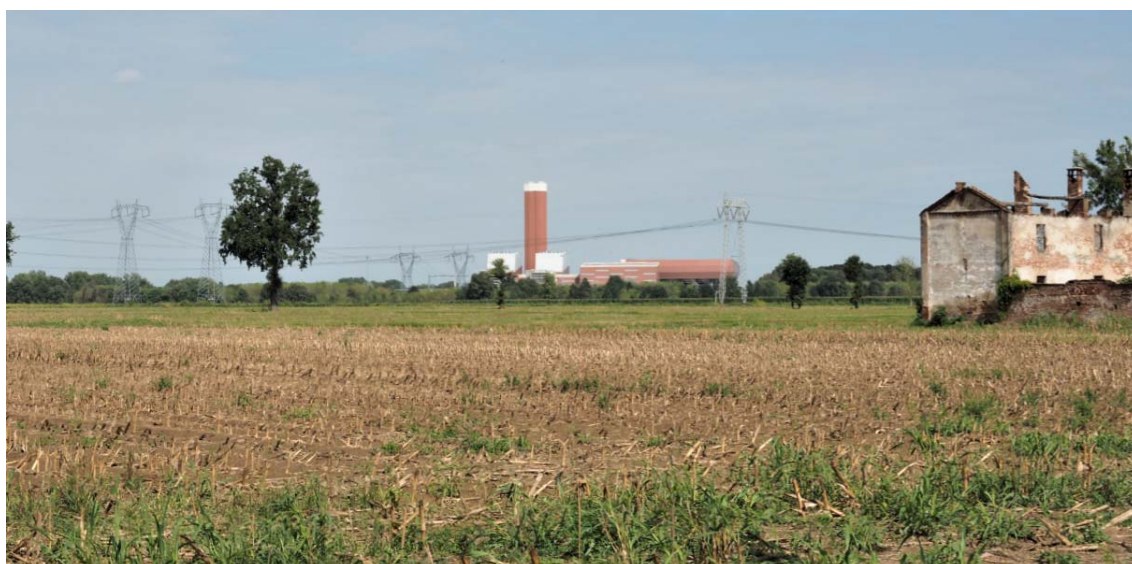
Figura 4-40: Vista della Centrale Sorgenia Power da Sud
