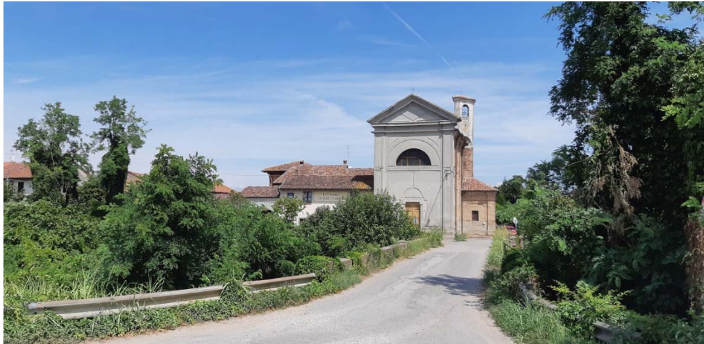
Figura 4-37: Ponte storico sulla Muzza presso la cascina Colombina, a nord-est dell'area.
