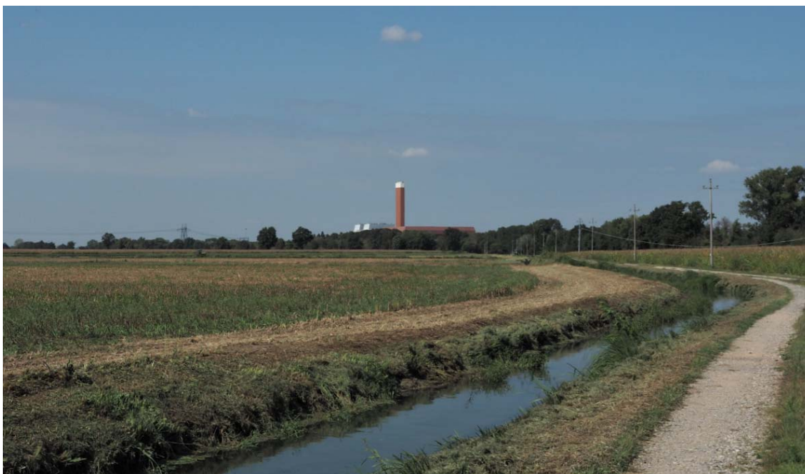
Figura 4-42: Vista della Centrale Sorgenia Power da Sud-Est
