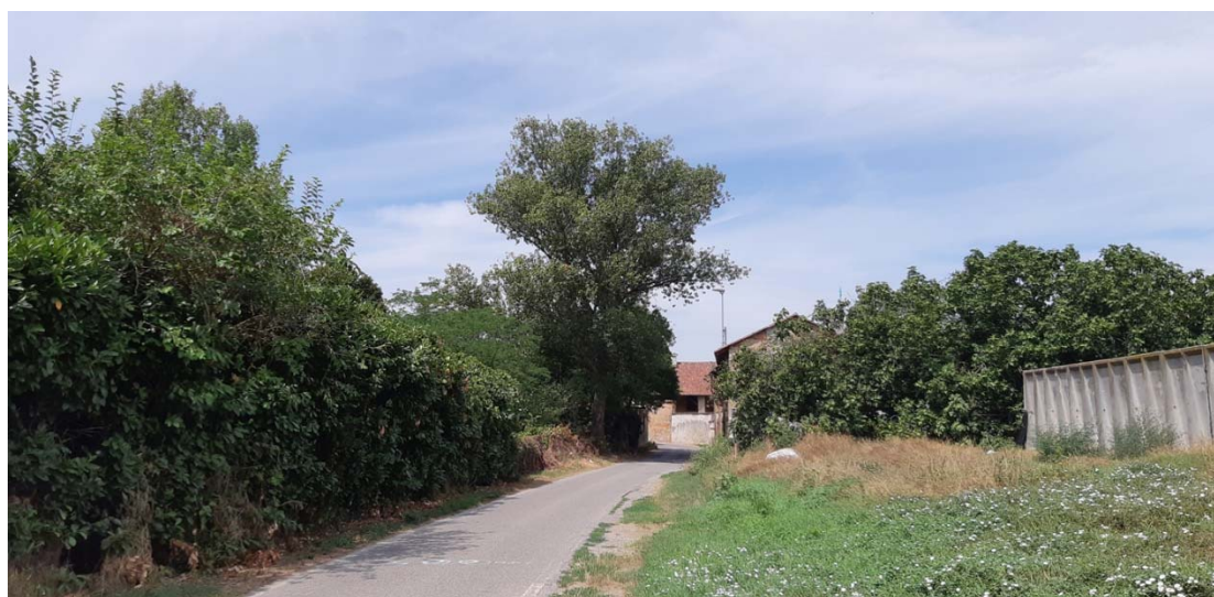
Figura 4-33: Melegnanello, centro di antica formazione rurale, attraversato dalla SP 222
