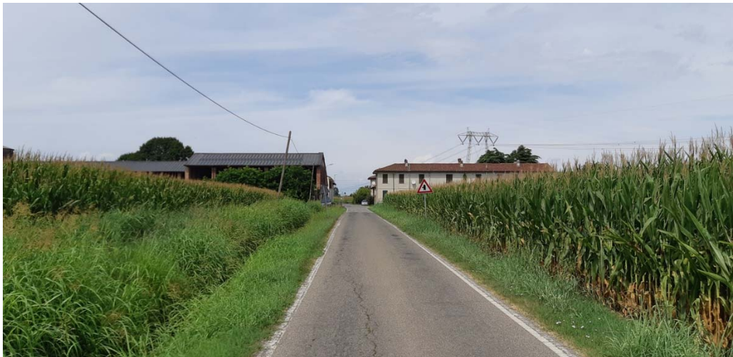
Figura 4-36: La cascina Buongodere attraversata dalla SP 222 a ovest dell'area in esame
