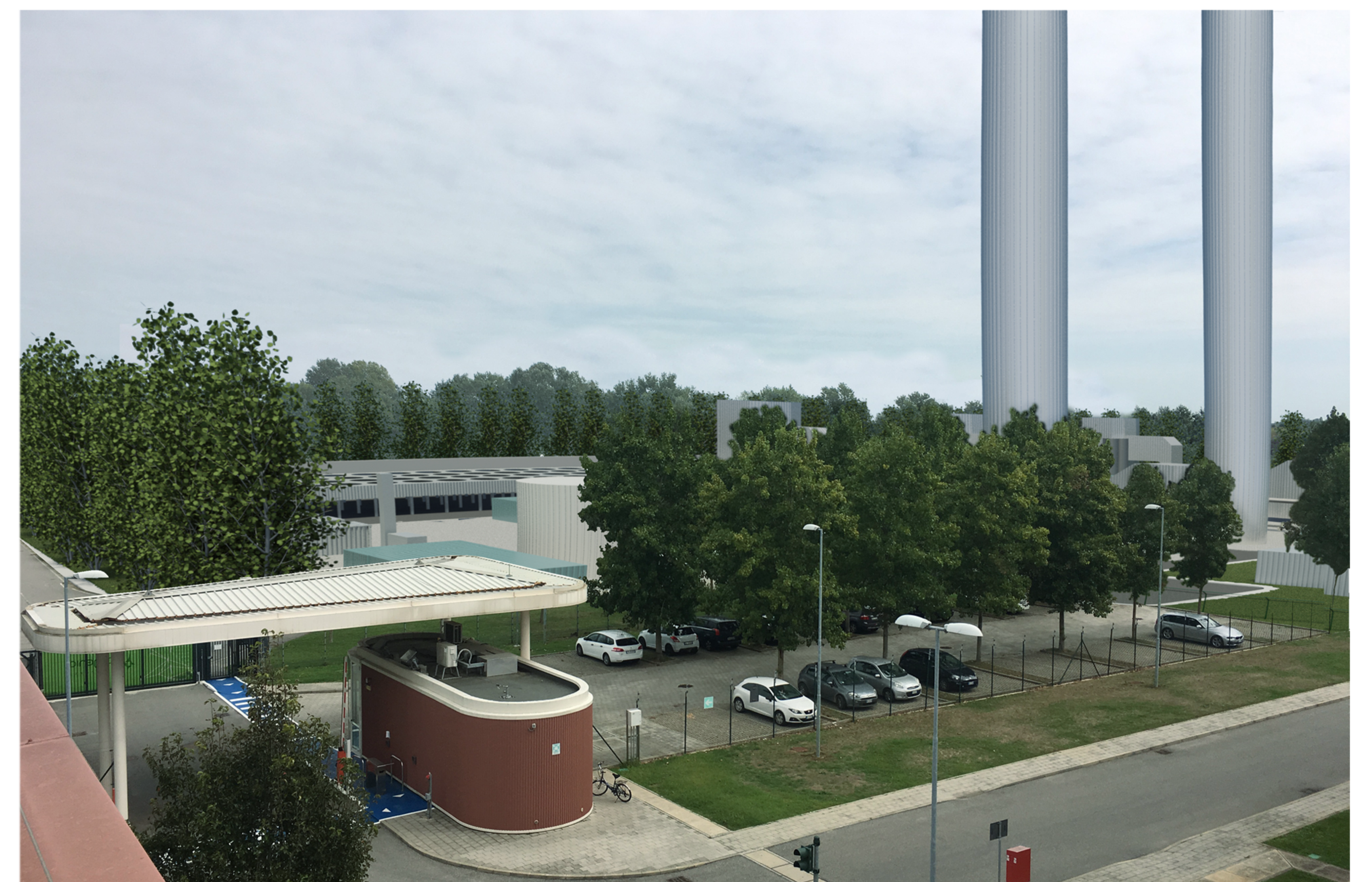
Vista del nuovo impianto dall'ingresso della centrale esistente
