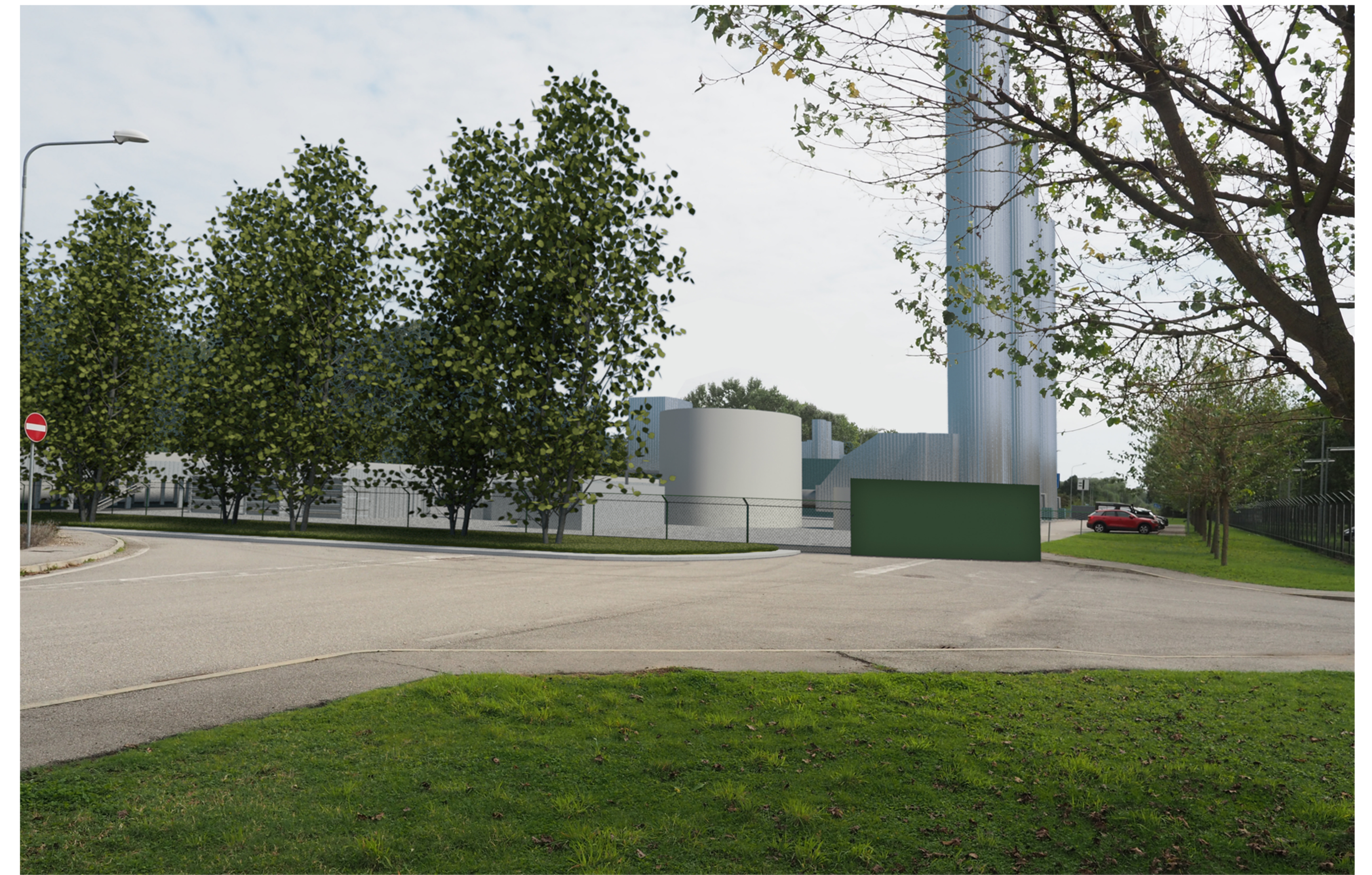
Vista dell'impianto da area in prossimità dell'ingresso della centrale esistente
