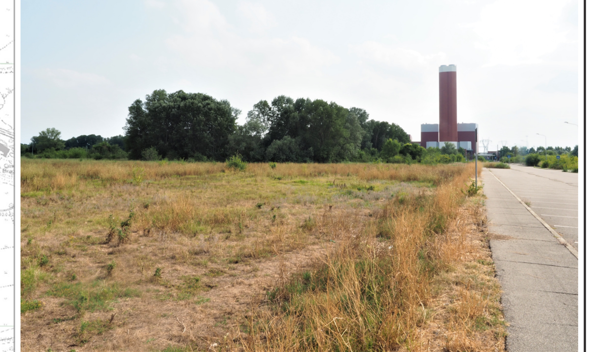
5_ Vista dal viale di accesso interno all'area industriale
