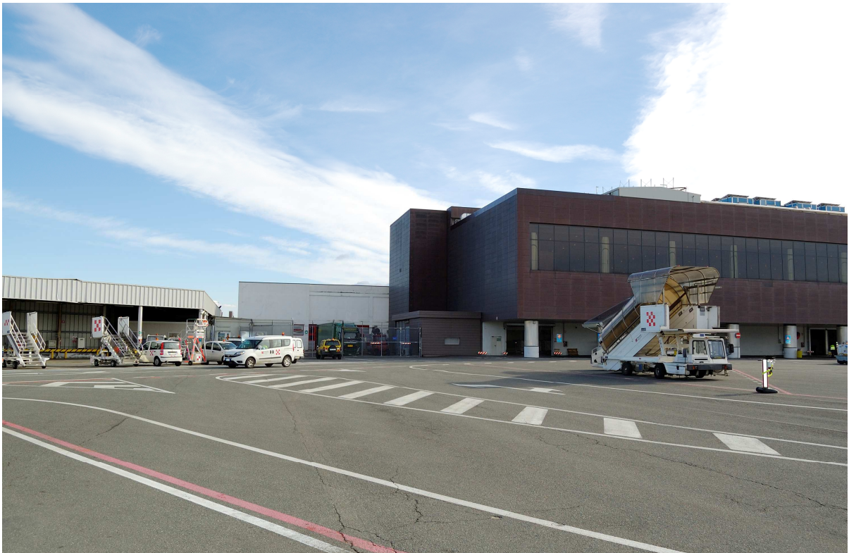
Figura 36 - Vista Air-side – Stato Attuale
