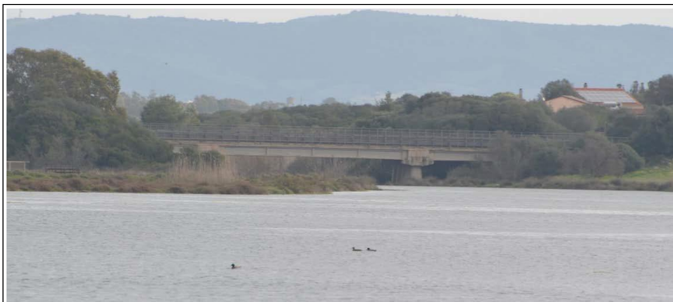
Figura 16 – Stagno del Calich ponte sul Rio Barca
