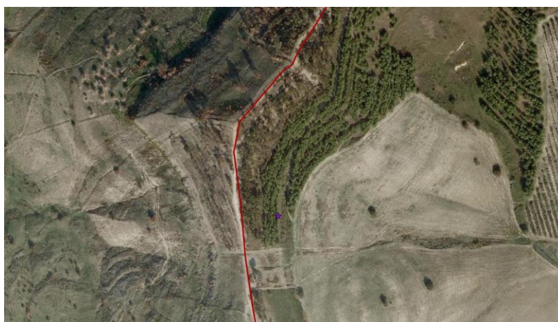
Fig.16 Volo Regione Calabria 2000 (base CTR). Visione del territorio in cui ricade la torre in C5
