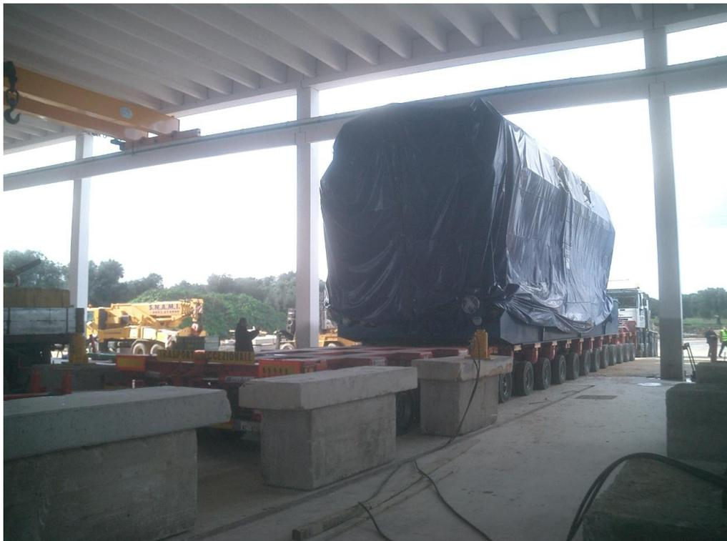
Figura 13 – Foto di repertorio 3 – Trasporto e posizionamento motogeneratori
