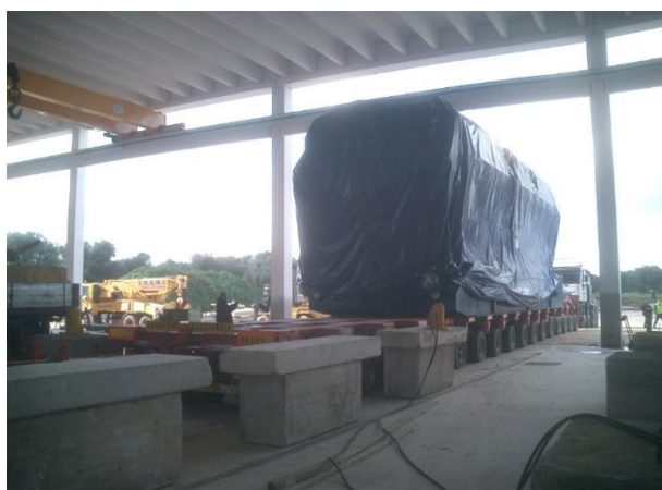
Figura 29: Foto di repertorio 3 – Trasporto e posizionamento motogeneratori
