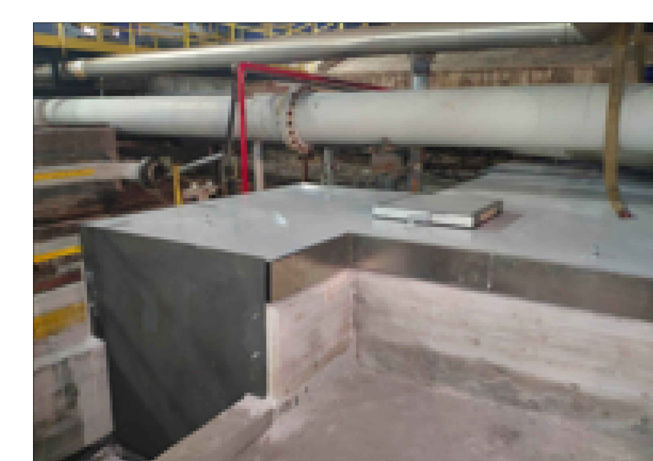
FOTO 5 COPERTURA FISSA CON PORTELLI DI ISPEZIONE E CARTER II DI COLLEGAMENTO A COPERTURA FLUTTANTE
