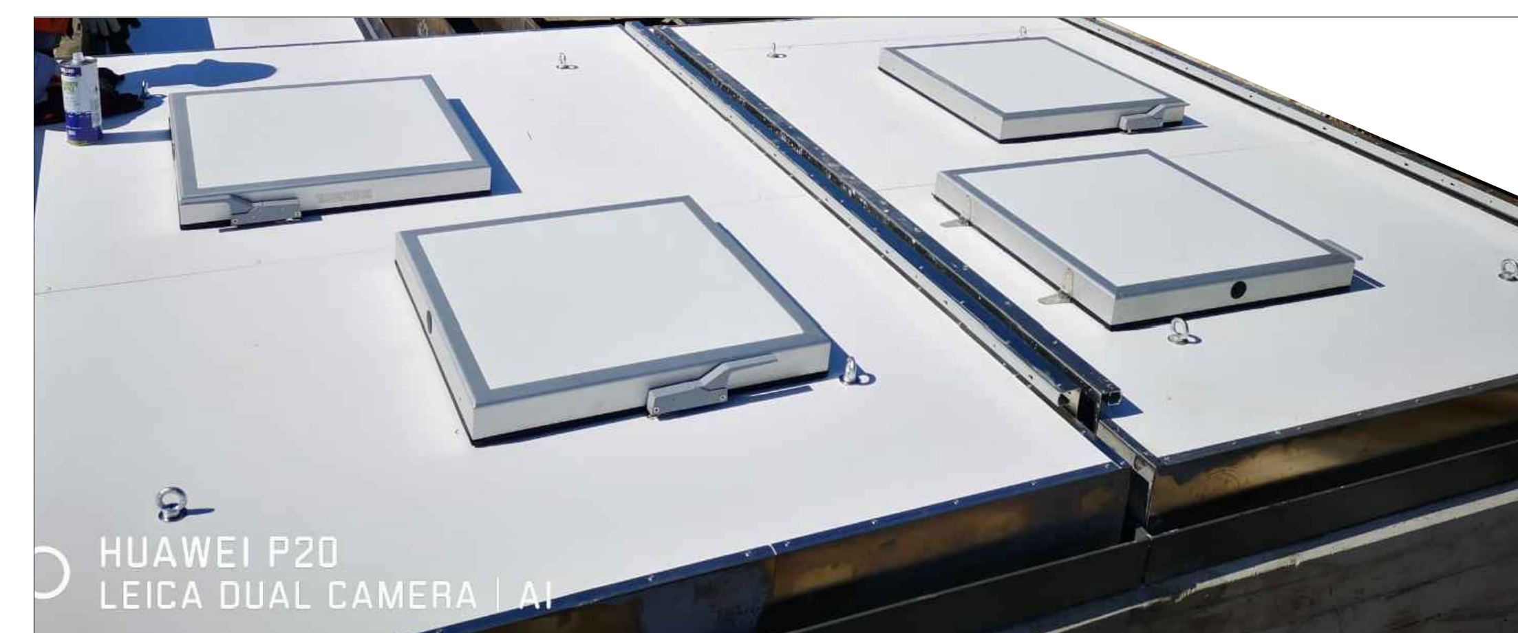
FOTO 4 PUNTO DI ARRIVO DEI DRENAGGI
