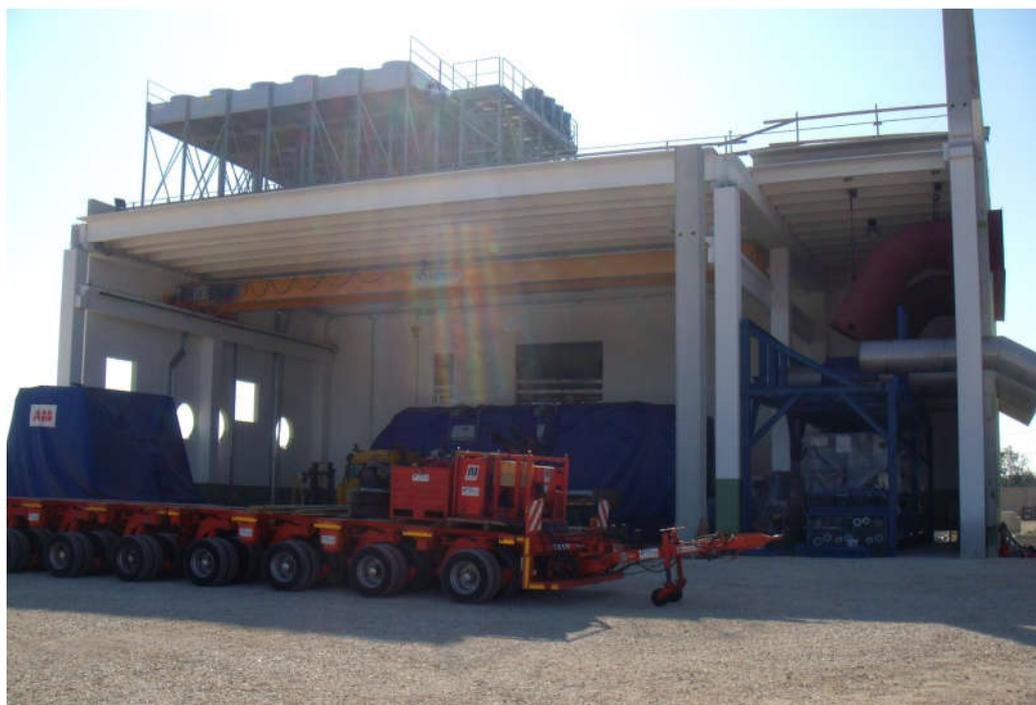
Figura 6 – Foto di repertorio 1 – Posizionamento Motogeneratori dal prospetto est
