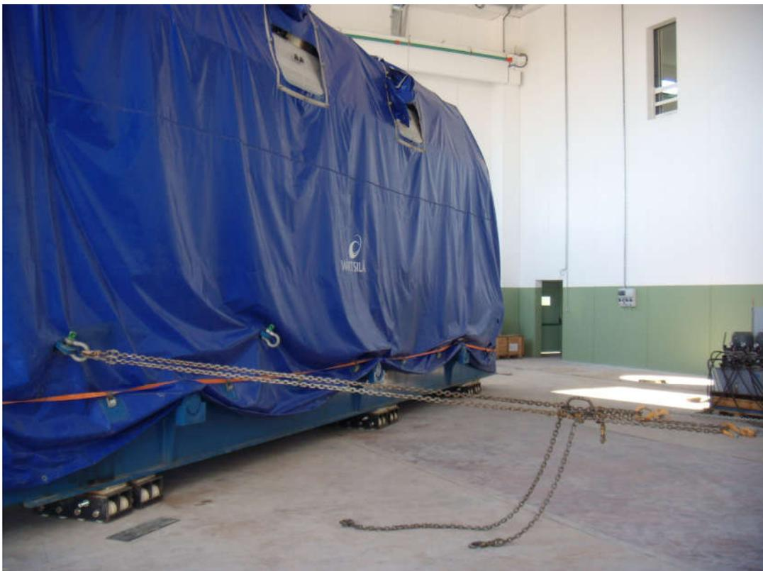
Figura 8 – Foto di repertorio 2 – Rotazione motore con “carriarmati”
