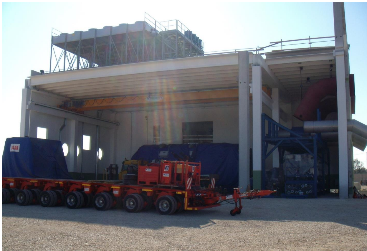
Figura 24: Foto di repertorio 1 – Posizionamento Motogeneratori dal prospetto est
