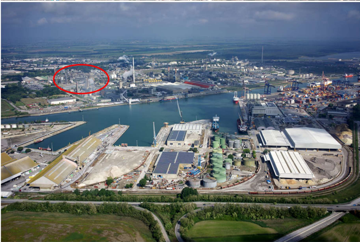
Figura 8.2.A – Foto aeree Sistema Canale Candiano – Darsena - Zona industriale. In rosso l'area di intervento (Fonte: in alto ravennadomani.blogspot.com, in basso ravennatoday.it)
