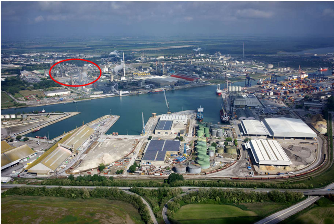
Figura 3.E - Foto aeree Sistema Canale Candiano – Darsena - Zona industriale. In rosso l'area di intervento (Fonte: in alto ravennadomani.blogspot.com, in basso ravennatoday.it)
