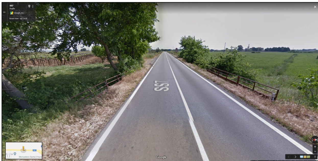
Figura 5-21 Canale da CTR n. 3 - km 611+631 della SS7
