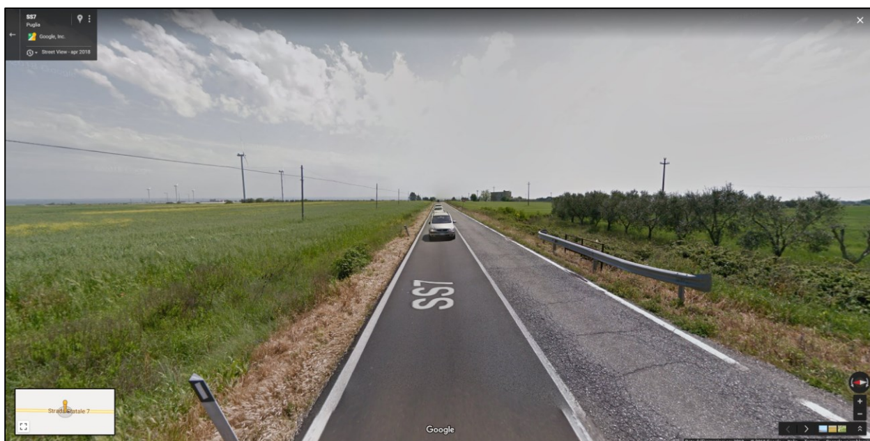
Figura 5-18 Canale da CTR n. 2 - km 608+547 della SS7
