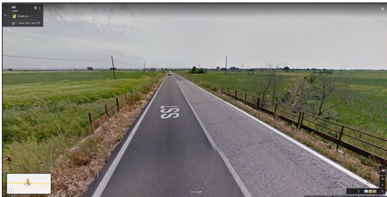
Figura 5-19 Corso d'acqua episodico n. 1 dell'AdB - km 609+335 della SS7
