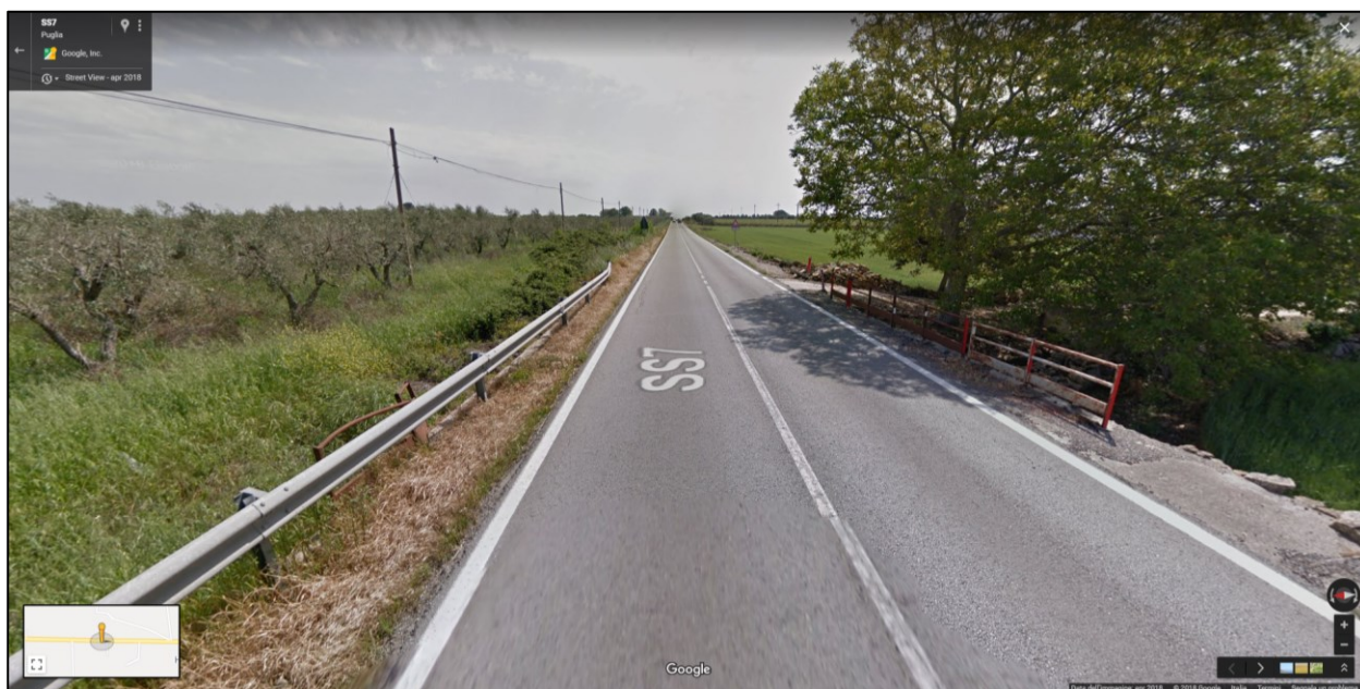
Figura 5-20 Corso d'acqua episodico n. 2 dell'AdB - km 610+565 della SS7
