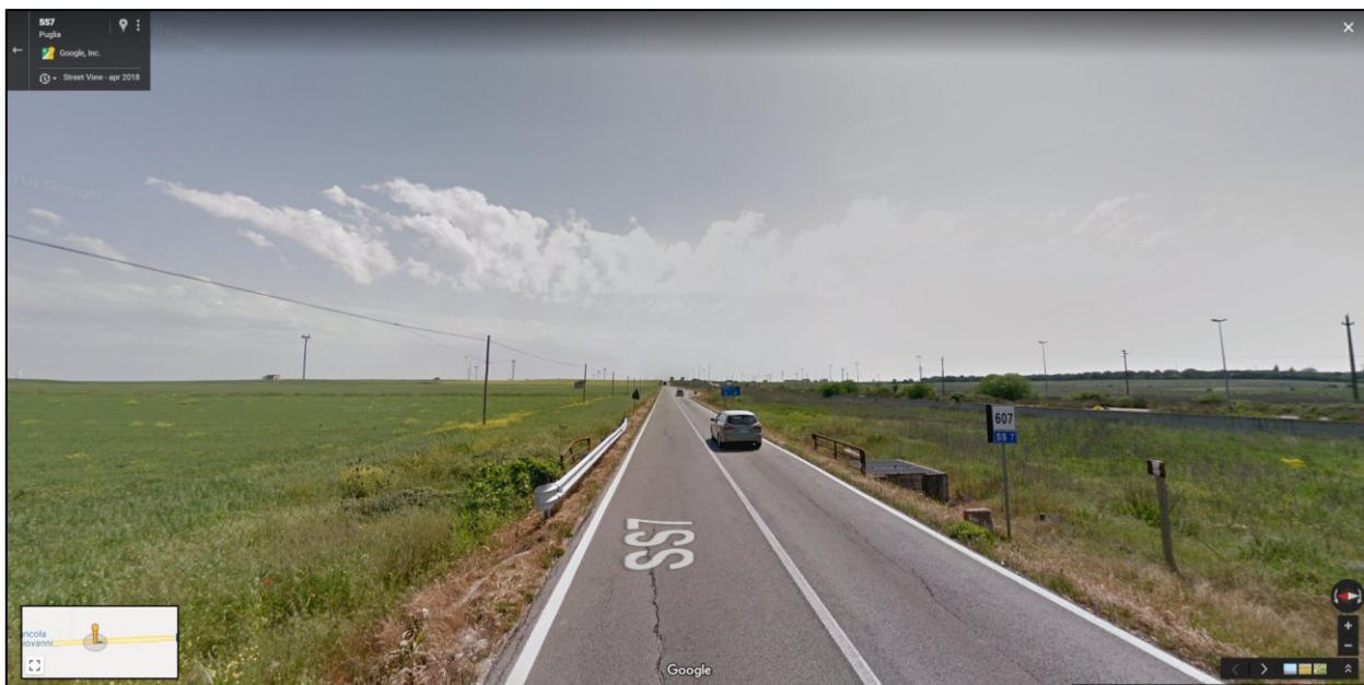
Figura 5-17 Canale da CTR n. 1 - km 607+006 della SS7
