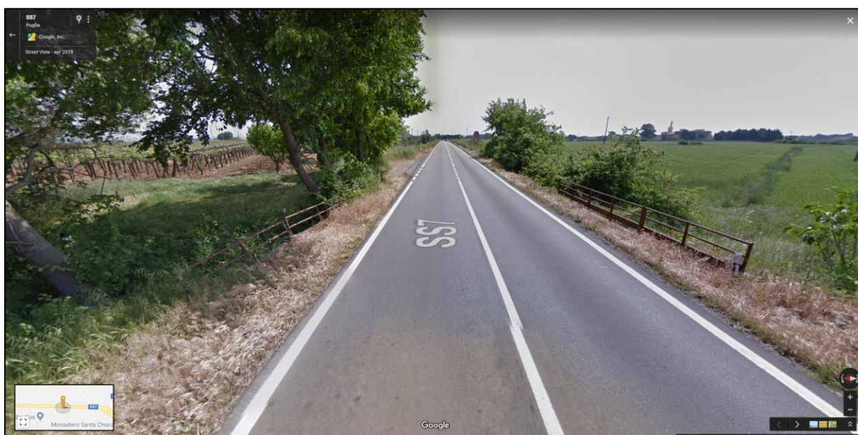
Figura 5-7 Canale da CTR n. 3 - km 611+631 della SS7
