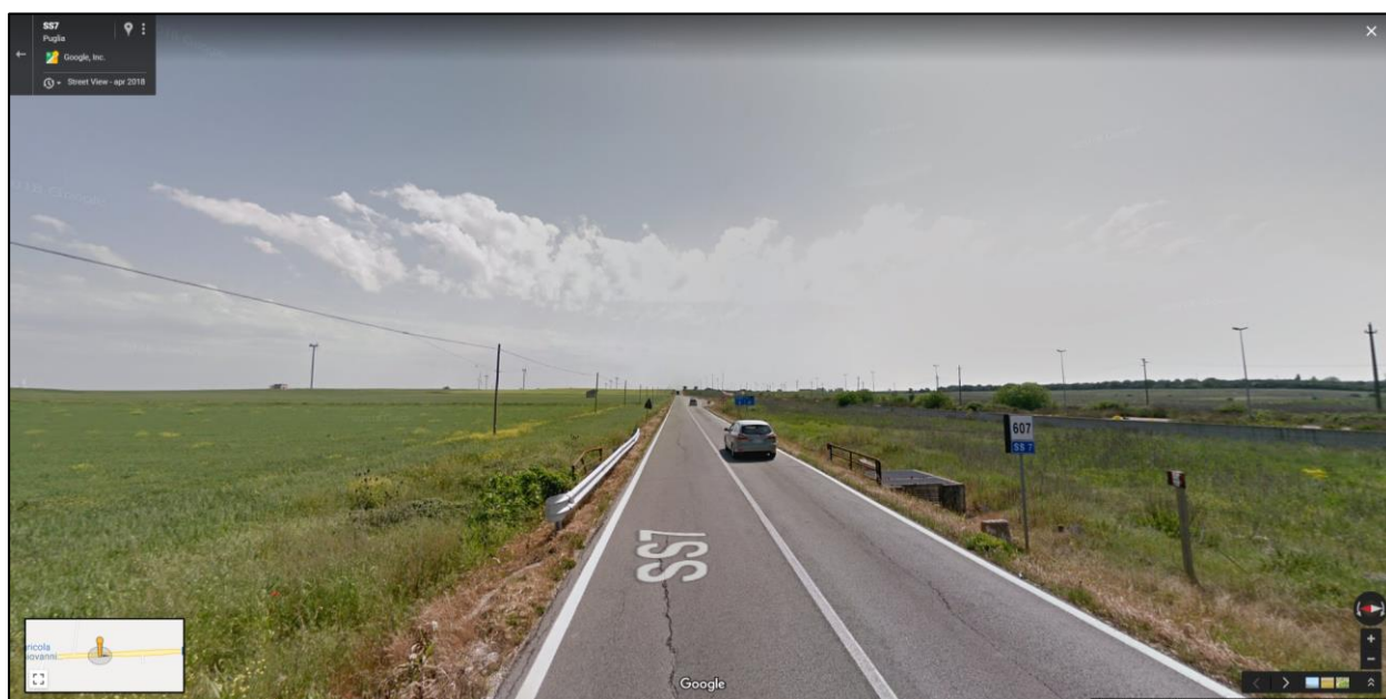
Figura 5-3 Canale da CTR n. 1 - km 607+006 della SS7
