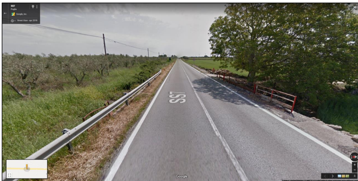
Figura 5-6 Corso d'acqua episodico n. 2 dell'AdB - km 610+565 della SS7
