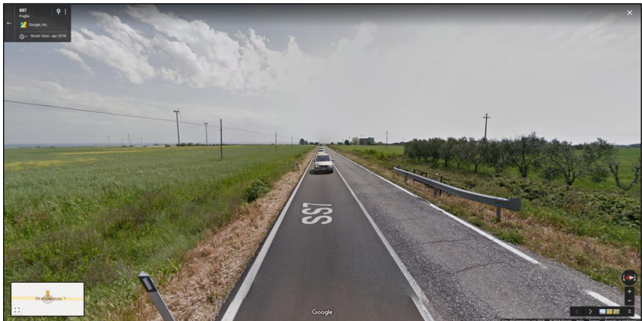
Figura 5-4 Canale da CTR n. 2 - km 608+547 della SS7
