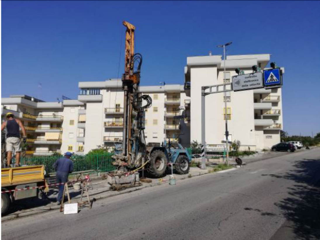
Figura 12 - Sondaggio S14 in corrispondenza dell'area PG3
