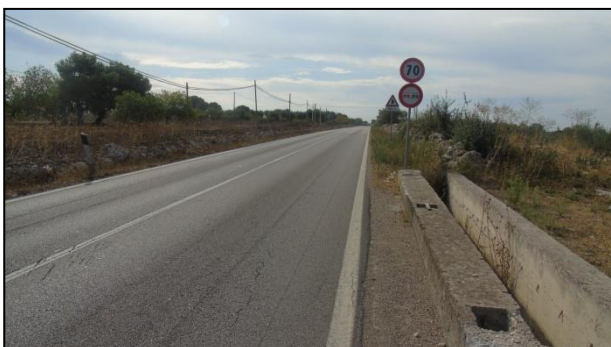
Fig. 18, 19, 20. Castellaneta (TA). "Progetto per la realizzazione della rete idrica dell'abitato di Castellaneta e potenziamento del serbatoio". Immagine nei pressi del tratto di statale in cui i lavori prevedono la messa in opera delle condutture al disotto del piano stradale. Non è stato individuato alcun tipo di elemento archeologico.
