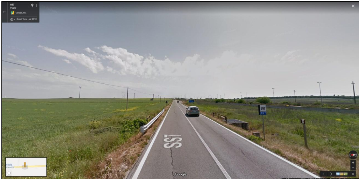
Figura 5-17 Canale da CTR n. 1 - km 607+006 della SS7
