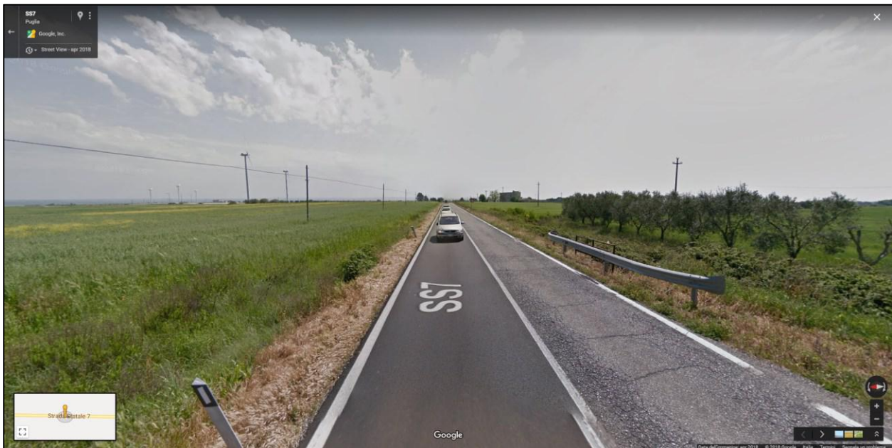
Figura 5-18 Canale da CTR n. 2 - km 608+547 della SS7
