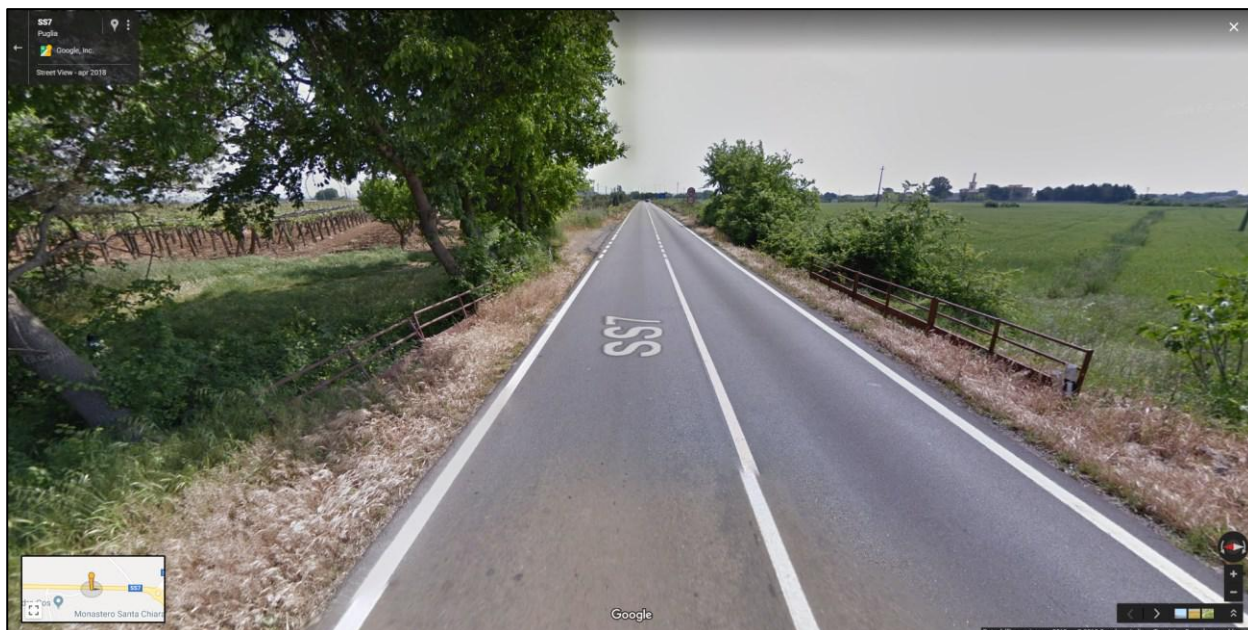
Figura 5-21 Canale da CTR n. 3 - km 611+631 della SS7
