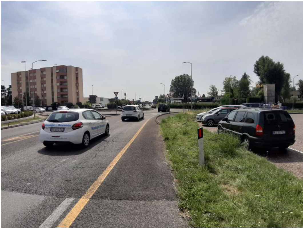
L'intersezione vista da Nord Ovest (SS13).
