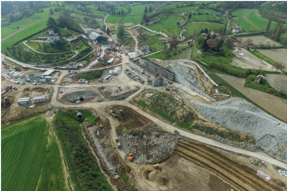
Ricettori all'altezza della Galleria III Valico Imbocco Nord
