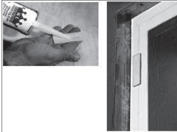
Posizionamento dello spessore per la correzione del piombo
