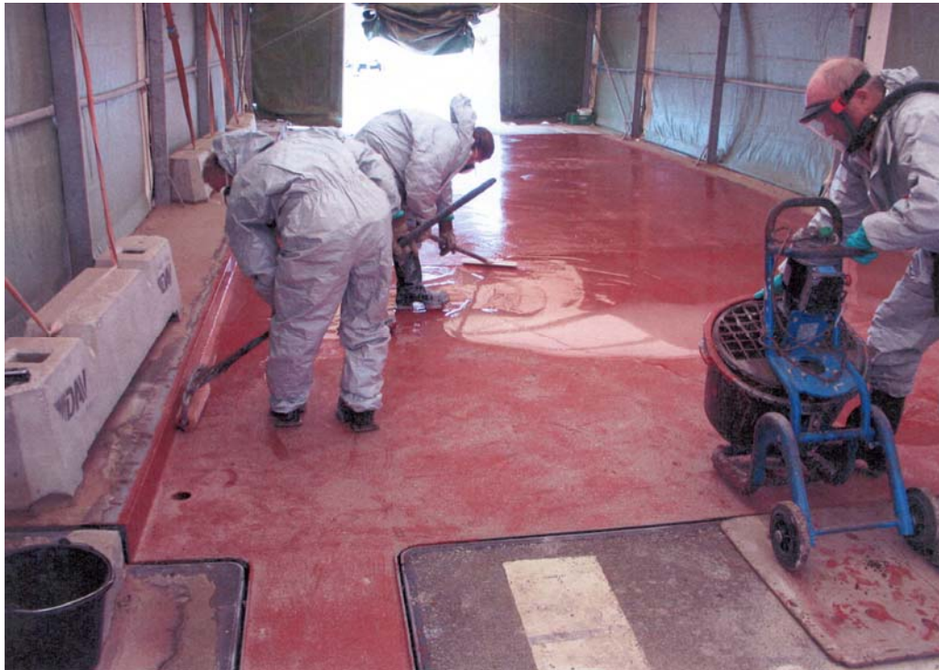
Figura 3 Applicazione della membrane a rullo
