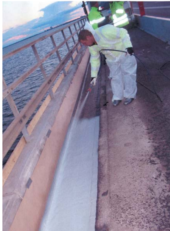
Figura 2 Applicazione del primer con spruzzo ad alta pressione
