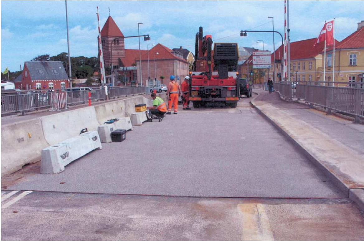
Figura 4 Rivestimento sottile completo su un piccolo ponte in Danimarca, 2010
