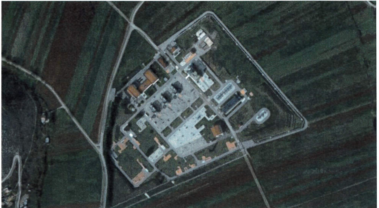
Figura 1 Vista aerea dell'impianto
