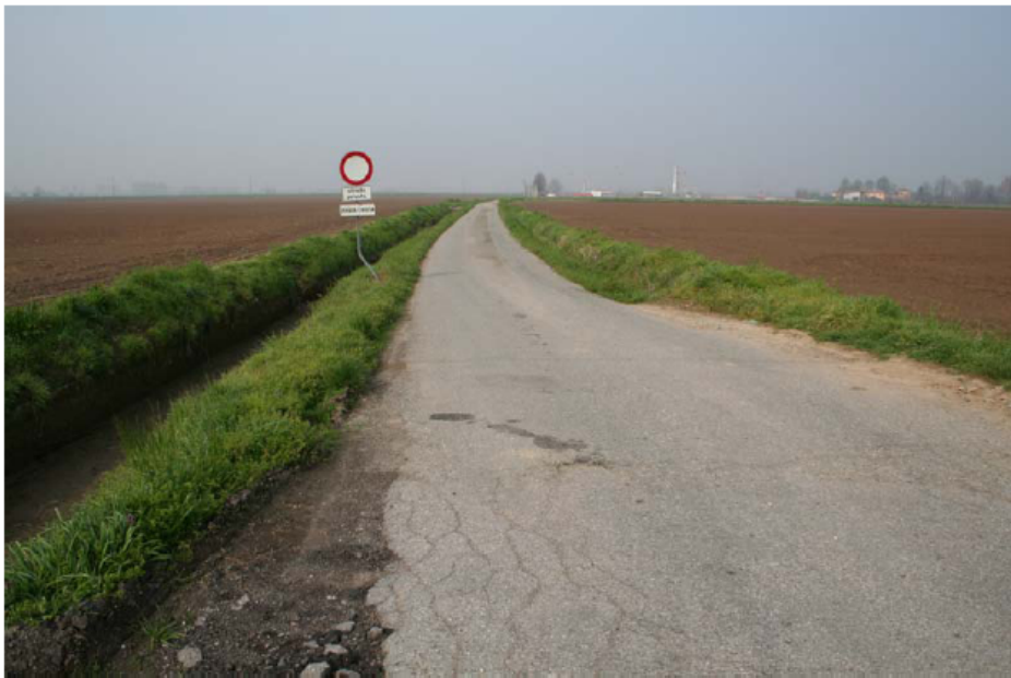
Foto. 10.3.a – Tratto di strada di accesso alla zona di costruzione della centrale
