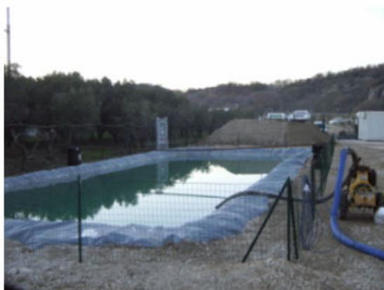
**Figura 4.1.2.c – Vascone per lo stoccaggio in cantiere dell'acqua industriale**
