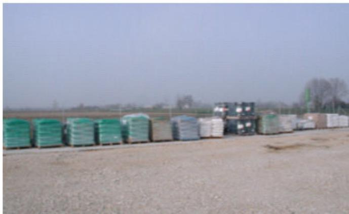
**Figura 4.1.2.d – Esempio di stoccaggio in cantiere degli additivi chimici**
