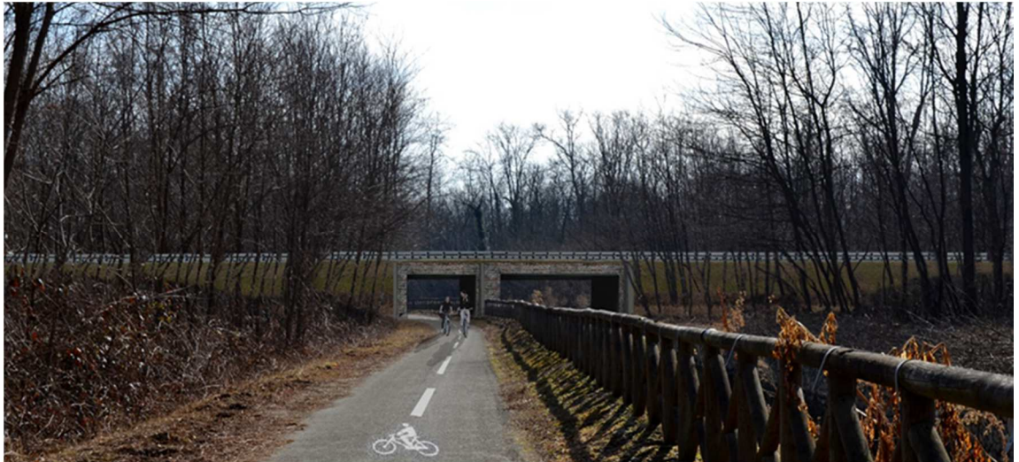
Figura 11 – Rivestimento portali sottovia ciclopedonali
