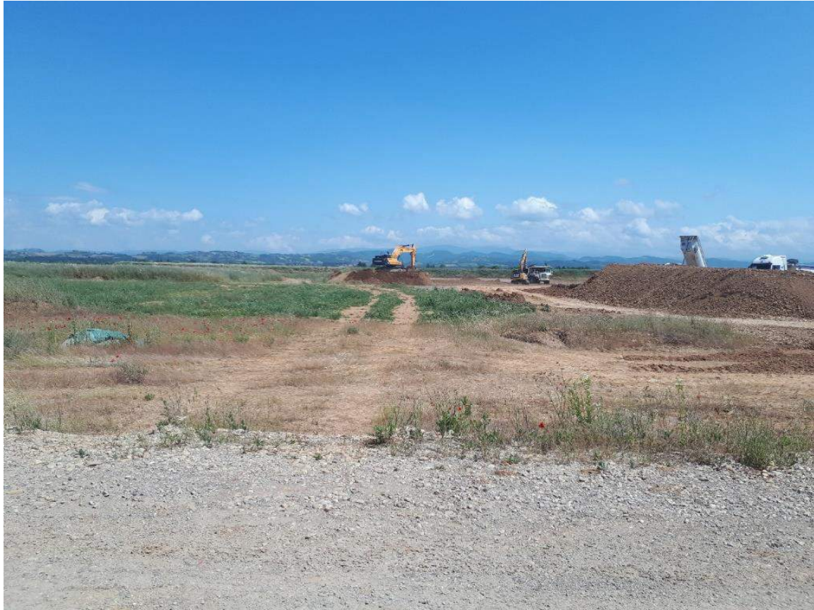
Figura 2 – Visuale sul sito di deposito di C.na Romanellotta, in una porzione in cui l'abbancamento è già stato concluso.
